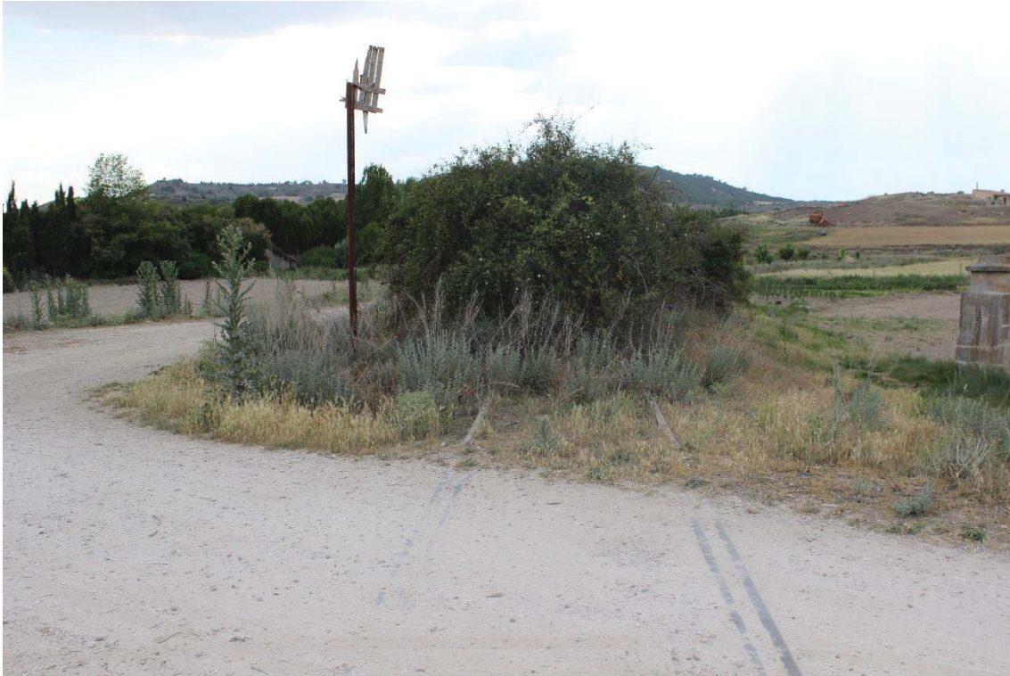
Entrada de la vía al municipio de Quintanilla de Arriba donde por su abandono la vegetación ha cubierto los raíles y para facilitar el paso por ella se ha cubierto de arena y grava. (Imagen propia)
