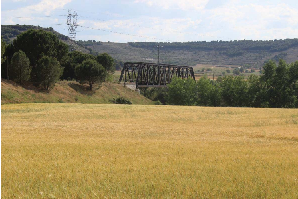
Puente de hierro por donde pasa la línea sobre el río Duero, este puente es el elemento más característico de Bocos del Duero asociado a este ferrocarril. (Imagen propia)
