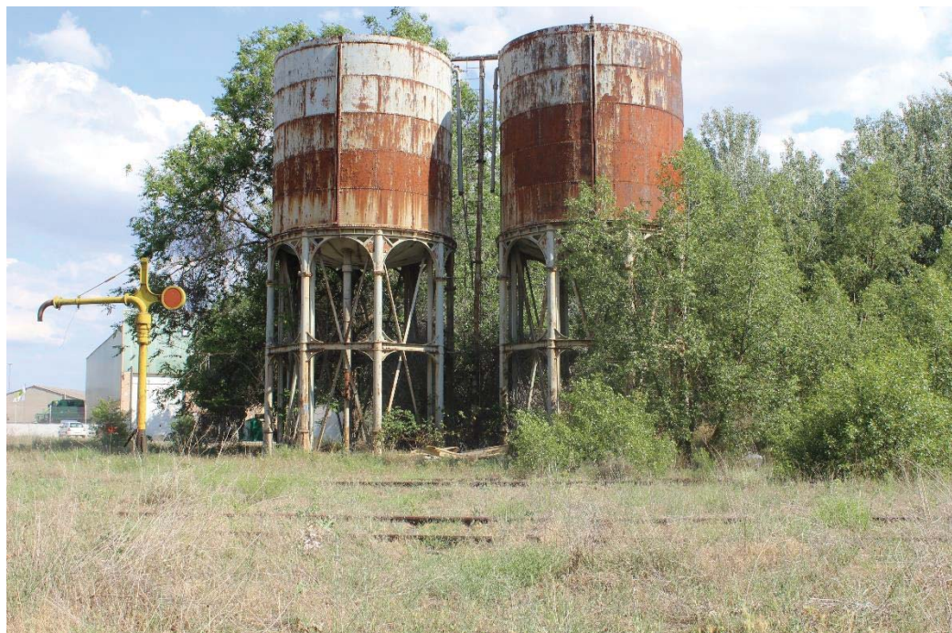
En la imagen se aprecia antiguos depósitos de agua y su correspondiente “grifo”, que se utilizaban para llenar las locomotoras de vapor. Como se puede apreciar, su estado es abandono total. (Imagen propia)
