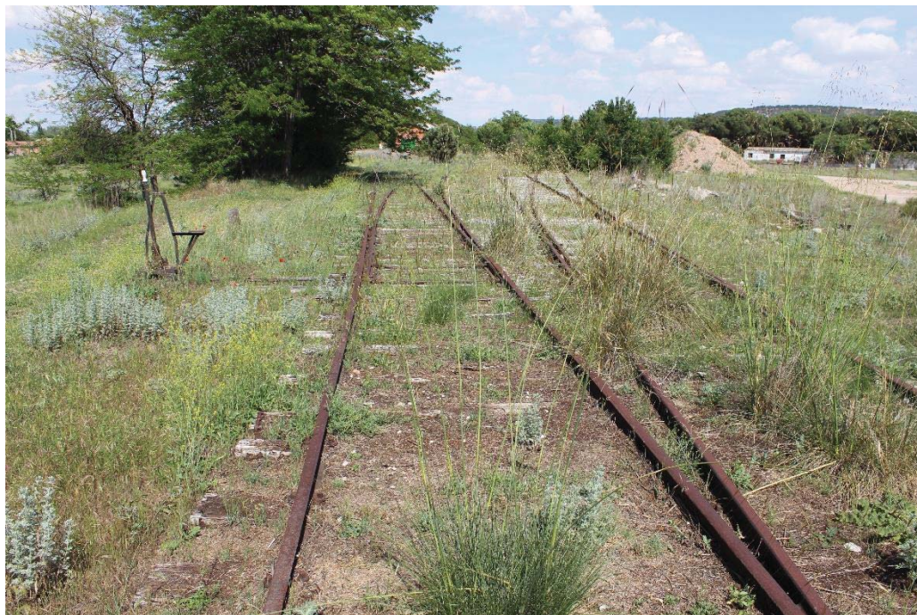
Cruce de vías antes de la llegada a la estación de Sardón de Duero, como se puede apreciar, la vegetación ha crecido sobre la misma (Imagen propia)
