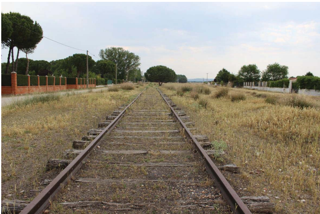
Paso de la línea por Traspinedo donde como se puede apreciar al final entra en zona de pinares. (Imagen propia)
