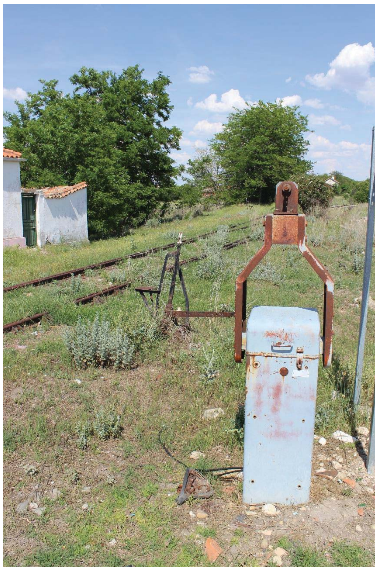
En la imagen tomada en Sardón de Duero, se aprecia a primera vista la barrera de paso a nivel, la cual esta oxidada y en evidente estado de abandono. (Imagen propia)
