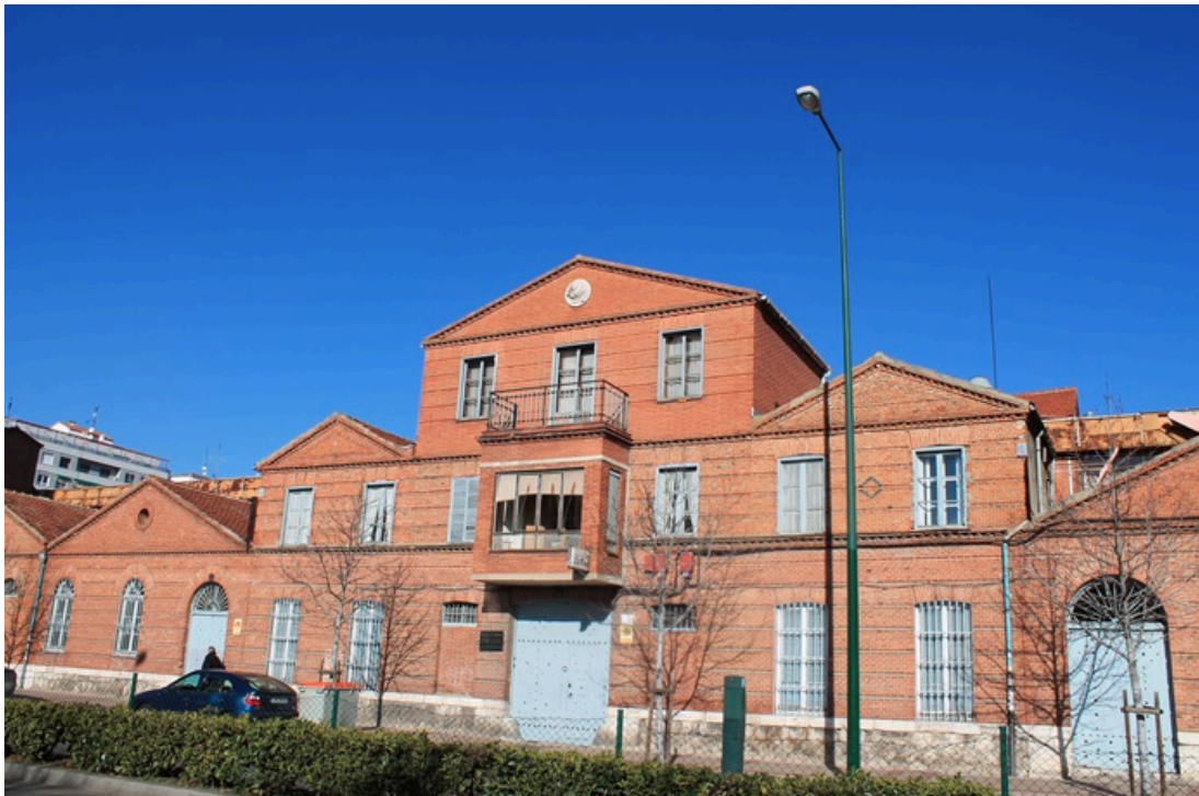
Imagen III.3.3.3.7. Estado actual de la fábrica de harinas “La Rosa” en la calle del Puente Colgante. ( https://jesusantaroca.files.wordpress.com/2015/02/8.jpg (última consulta 22/09/2017)).
