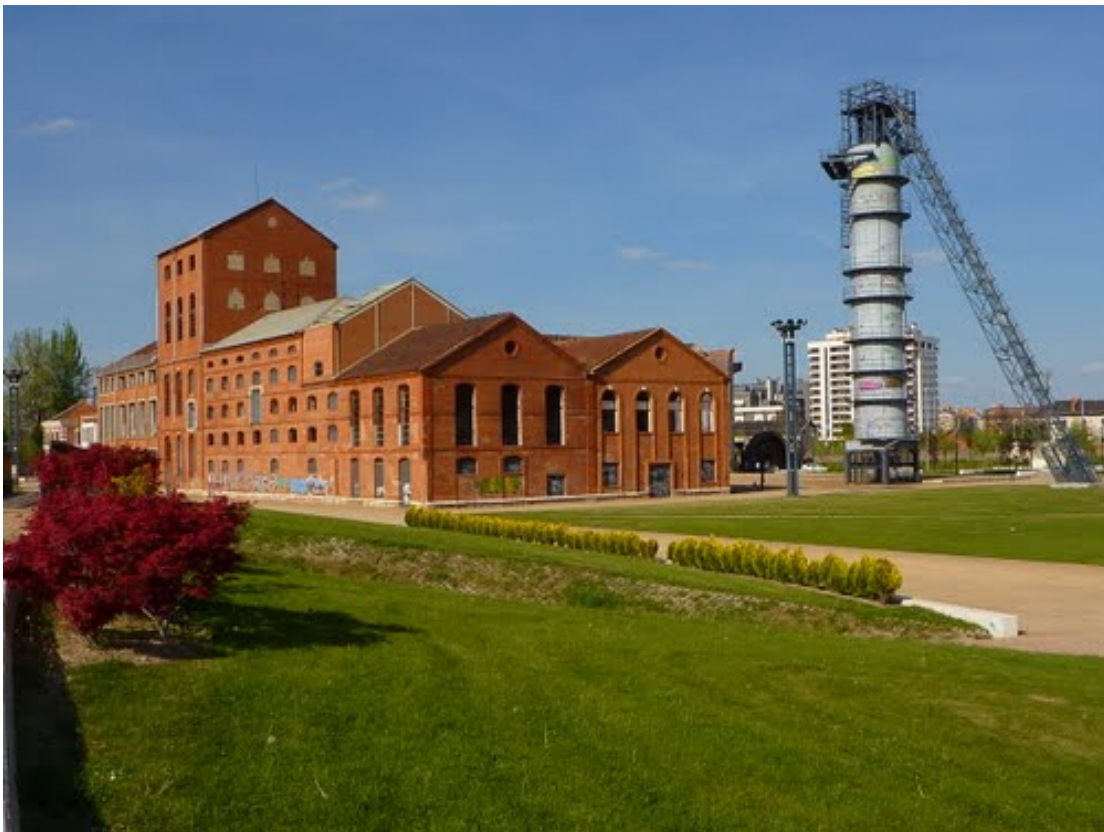
Imagen III.4.2.2. Aspecto actual de la azucarera Santa Victoria en Valladolid. Parque de Las Norias.
