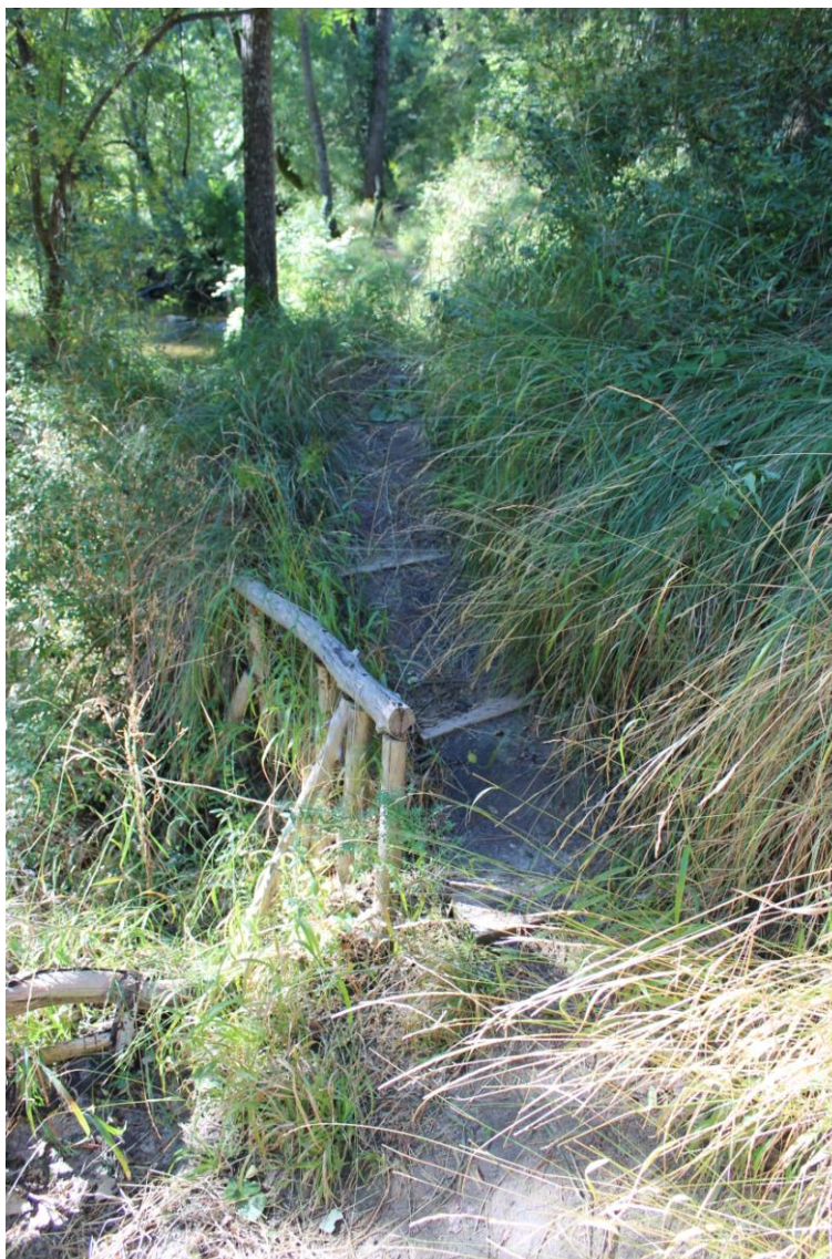
Figura 2. Ejemplo del estado actual de la senda.
