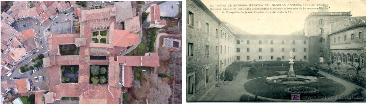
Figura 2. Intervención en el claustro y jardín de acceso.
