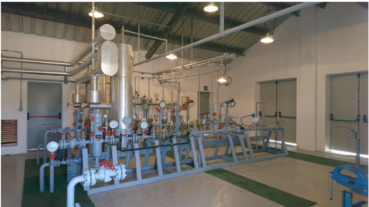
Figura 18. Estación de Regulación y Medida Pos. R03
