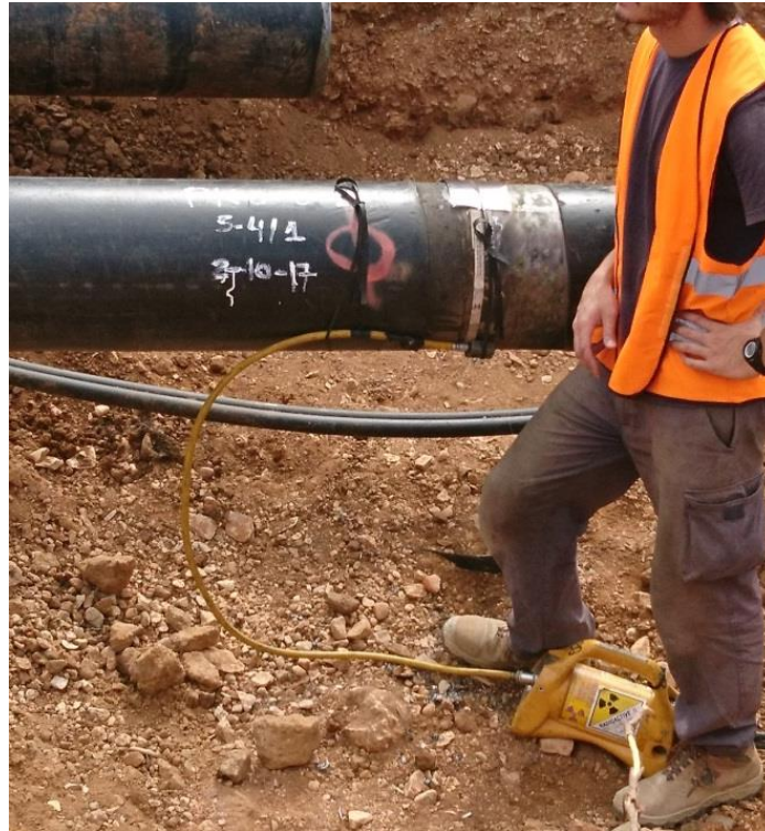
Figura 29. Radiografiado de la soldadura
