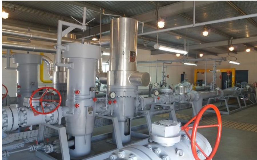
Figura 5. Estación de Regulación y Medida
