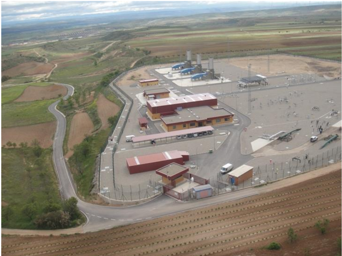
Figura 4. Estación de Compresión de Villar de Arnedo
