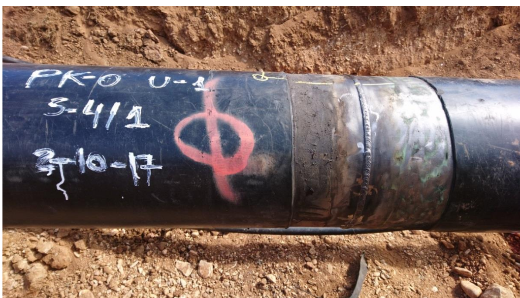
Figura 28. Cordón de Soldadura
