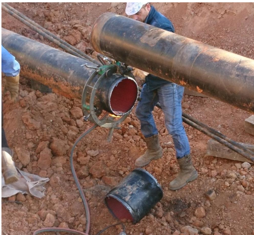
Figura 24. Corte del gasoducto
