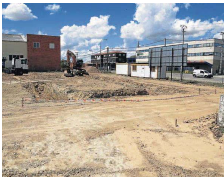
Ilustración 13. Construcción de la nueva planta de Cortes Metalúrgicos Oviedo. Fuente: El Norte de Castilla.
