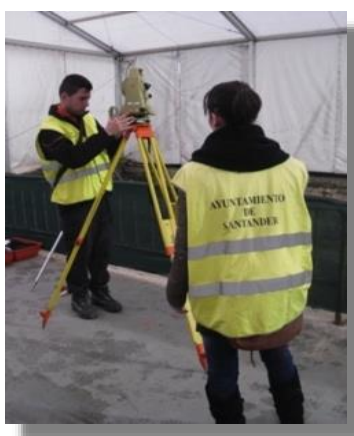
Figura 49. Equipo de Topografía.
