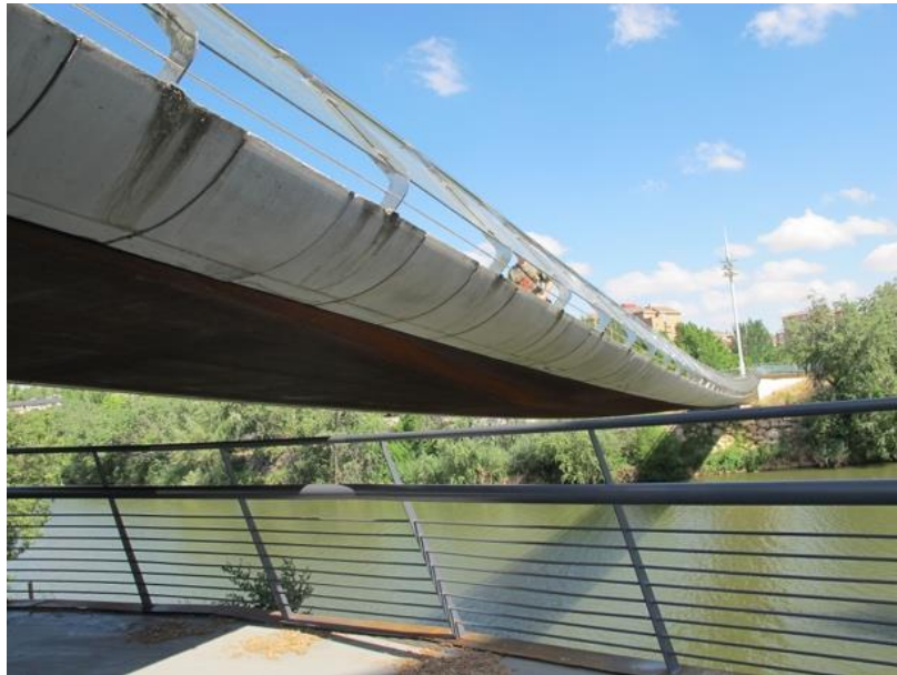
Figura 86. Pasarela Peatonal de Pedro Gómez Bosque en Valladolid.
