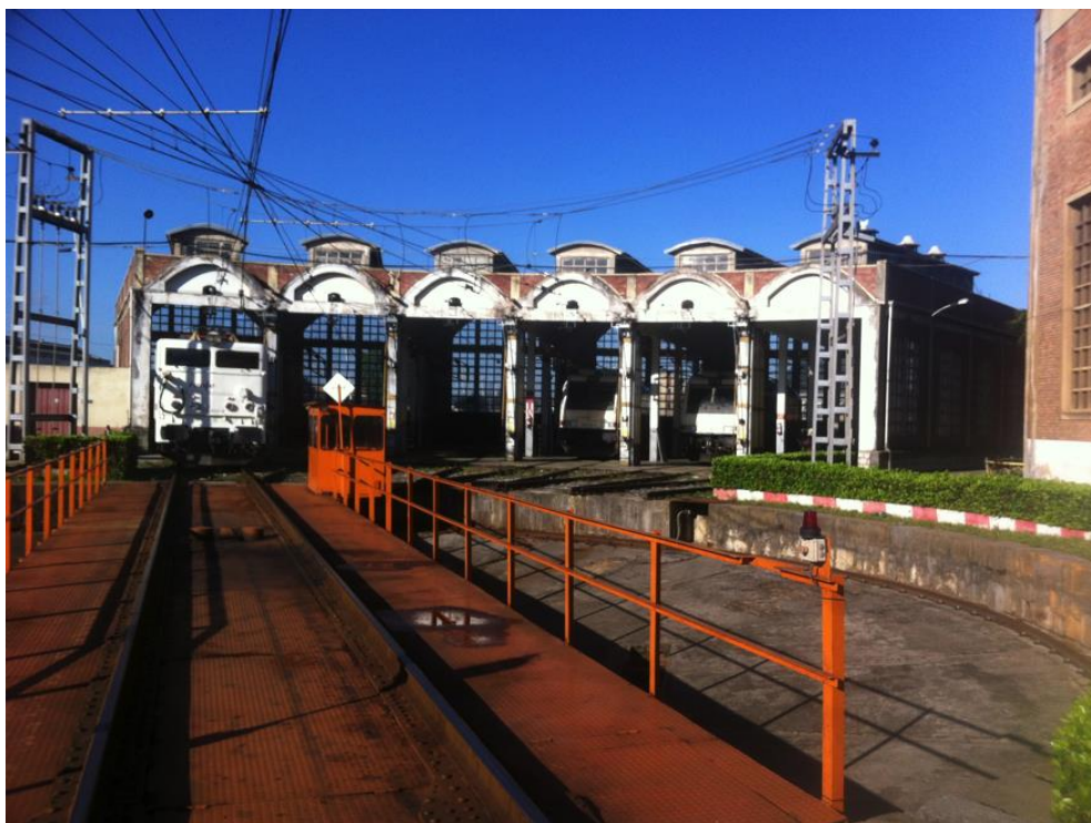
Figura 63. Depósito de locomotoras Cajo-Santander.
