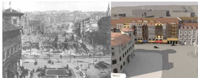
Fig. 3. La Ribera tras el siniestro. En primer plano, a la izquierda, edificio de Correos (Fuente: CDIS). A la derecha, reconstrucción Virtual de la Ribera previa al siniestro.
