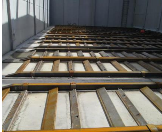
Imagen 37. Silo de almacenamiento del biocombustible.
