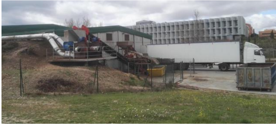
Imagen 40. Descarga de biocombustible al silo de almacenamiento (2).
