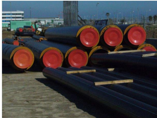
Imagen 22. Tuberías pre-aisladas para una red de distrito. Fuente ADHAC.
