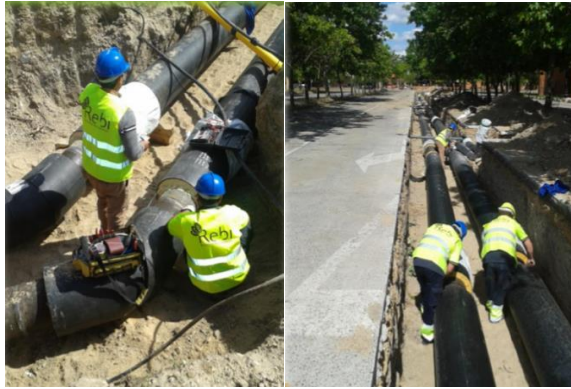
Imagen 56. Tuberías del DH en la zanja antes de ser cubiertas.
