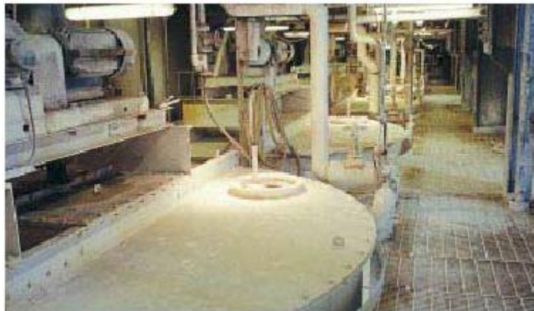
Figura 2.19: Tratamiento superficial previo al molido
