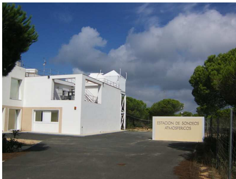
Figura II-4. La estación de Sondeos Atmosféricos de El Arenosillo (Huelva), perteneciente al INTA.
