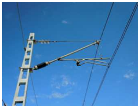
Figura 5.1 - Fotos de ménsulas correspondientes a las catenarias CR – 160 (izq.), y CR – 220 (dcha.).
