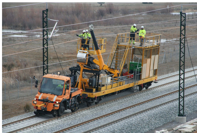
Imagen 3.6 – Tendido de cables en LAV Valladolid - León
