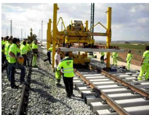
Imagen 3.4 – Tendido de vía en LAV Madrid – Valencia.
