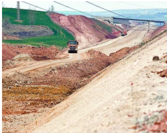
Imagen 3.1 – Trinchera para LAV.
