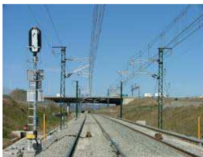
Imagen 4.9 – Postes de doble U que sostiene catenaria para alta velocidad.
