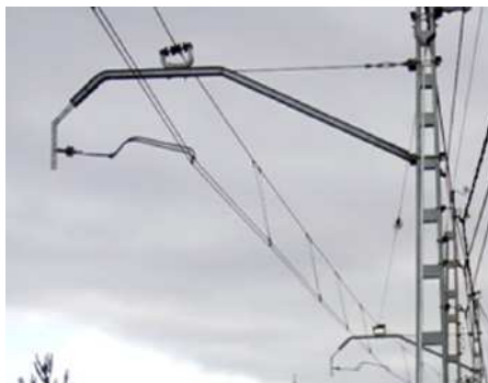
Figura 5.1 - Fotos de ménsulas correspondientes a las catenarias CR – 160 (izq.), y CR – 220 (dcha.).
