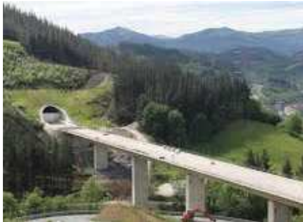
Imagen 3.2 – Túnel y viaducto para LAV
