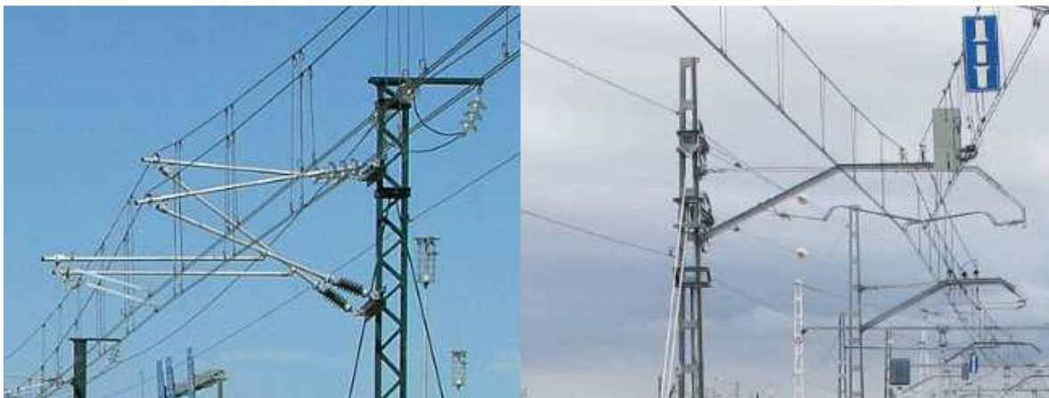
Imagen 4.6 - Ménsula tubular para alta velocidad, 25 kV (izq.); en celosía para línea convencional, 3.000 V (dcha.)
