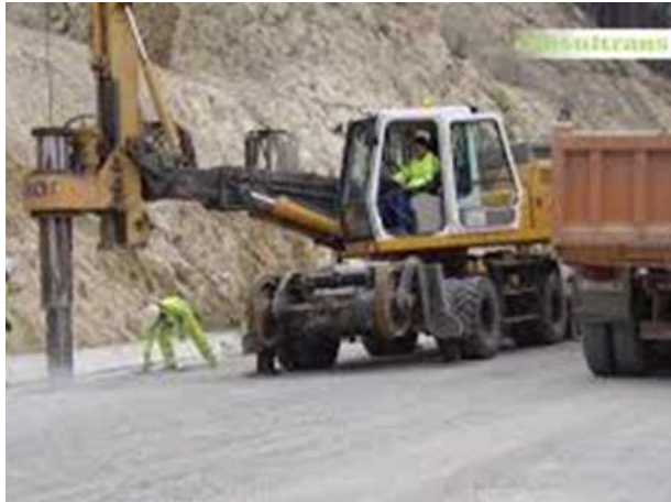
Imagen 3.5 – Máquina en labores de ejecución de macizos.
