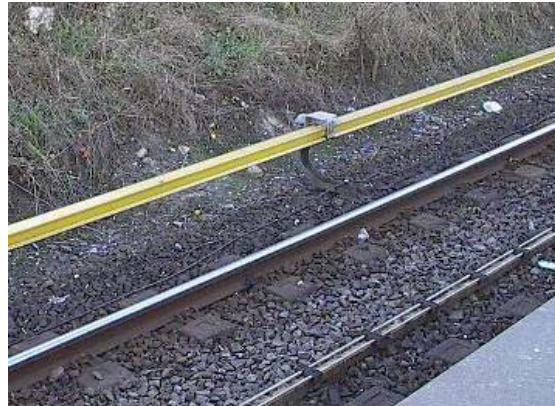
Imagen 2.3- Sistema de captación por tercer carril tradicional
