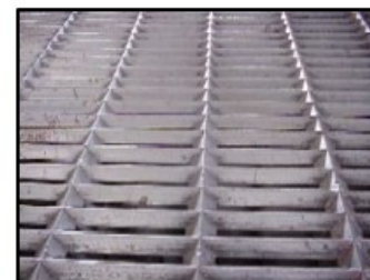
Figura 25: Suelo de la piqueta de descarga.
