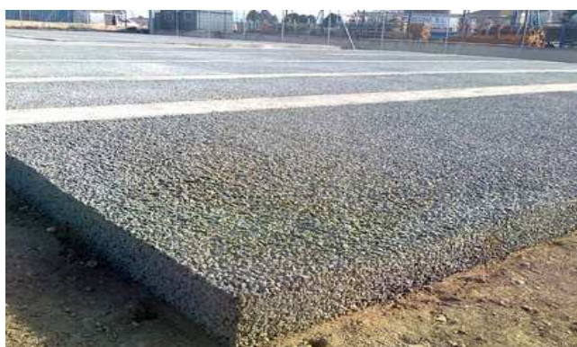
Ilustración 105. Pavimento de pista deportiva. (Fuente: https://www.construible.es )
