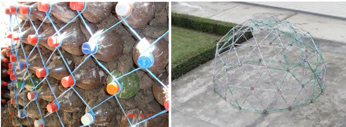
Ilustración 8. Muro con botellas PET rellenas de tierra y atadas por el tapón. Fuente. http://www.ddecoracion.com/arquitectura/construir-con-envases-de-pet/
