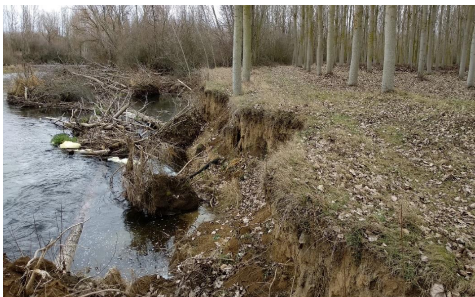
Fotografía 3: Detalle proceso erosivo
