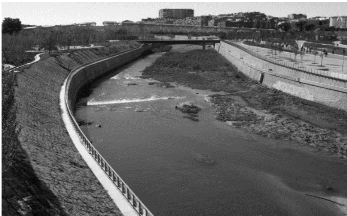
Fotografía 3: Muros de hormigón
