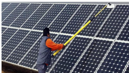
Imagen 5: Limpieza manual de módulos fotovoltaicos. (Fuente: SolarMurcia S.L.)
