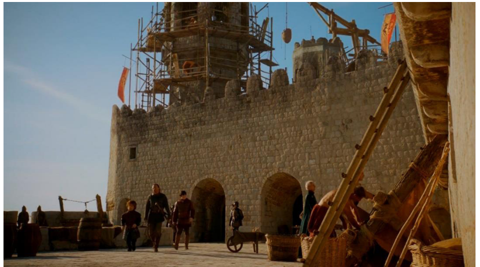
Imagen 20. Fotograma de Juego de Tronos . Reparación de la muralla.
