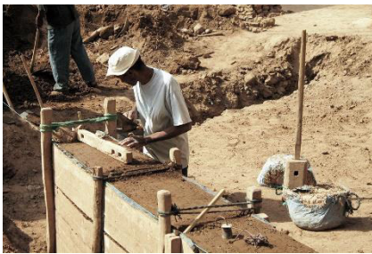
Imagen 72. Sistema de construcción en Ait-Ben-Haddou, Marruecos.
