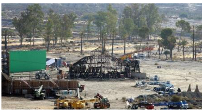
Imagen 87. Construcción del set de grabación en Almería, España.
