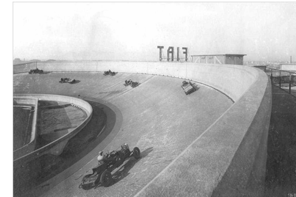
Cubierta edificio Fiat en Lingoto.
