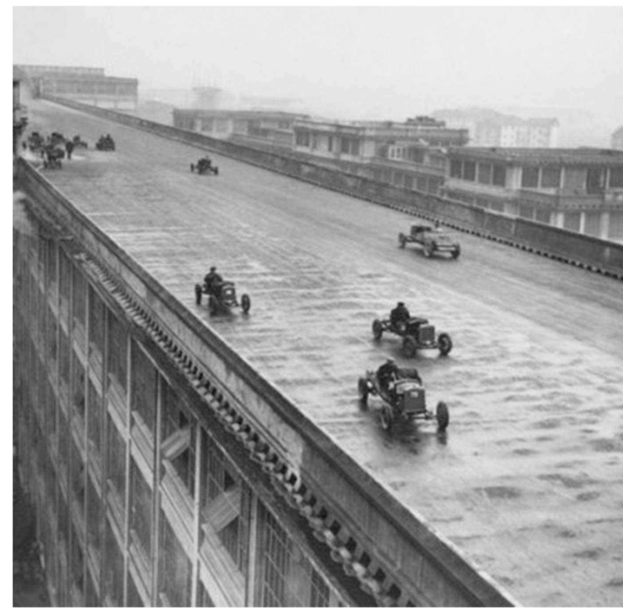
Cubierta edificio Fiat en Lingoto.
