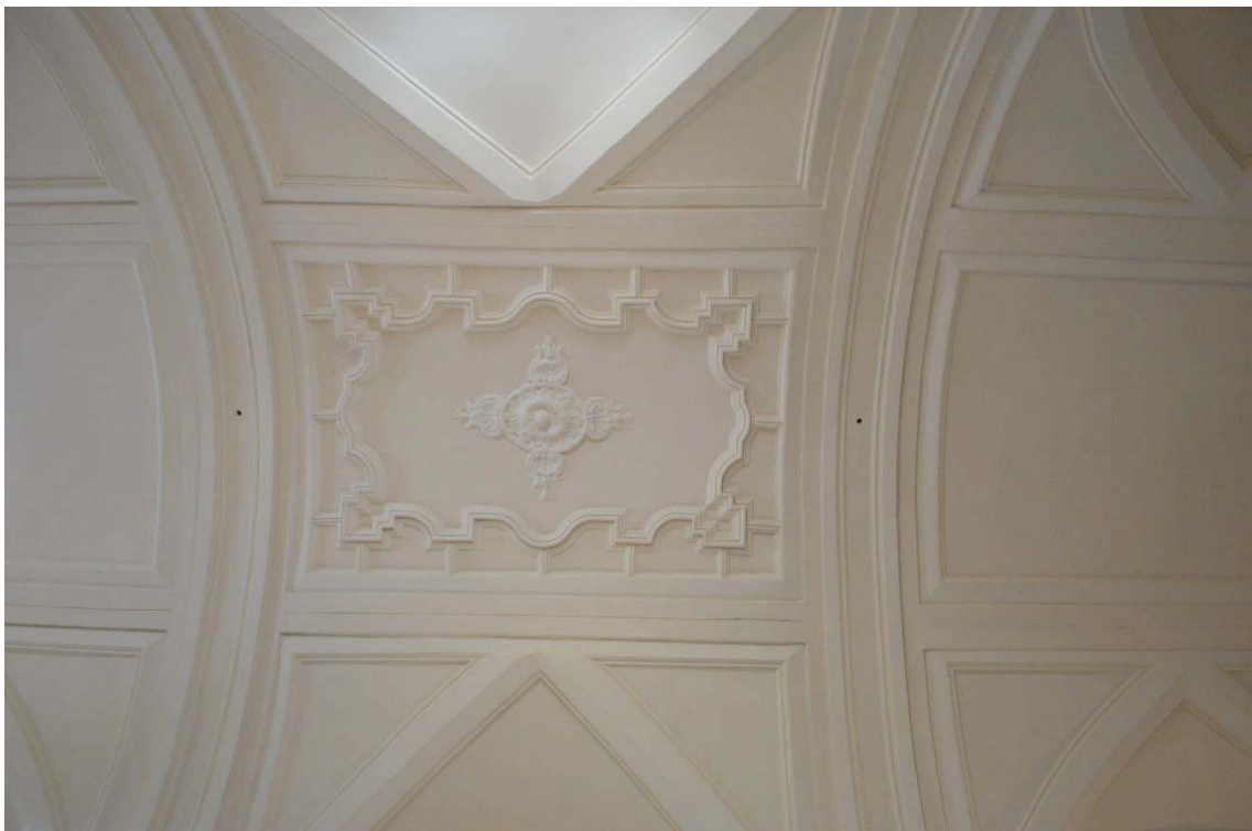
Fig. 14. Detalle de las bóvedas de la actual sacristía. Fuente: autora.
