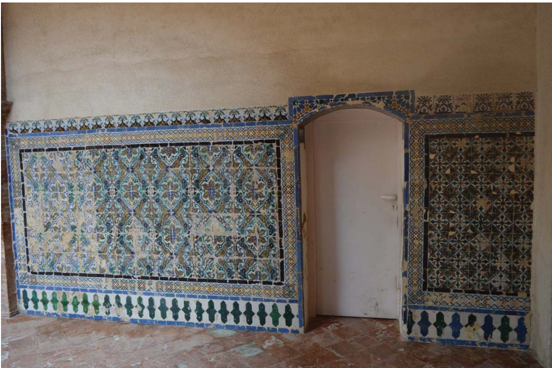
Fig. 31. Detalle de una pared interior del claustro con restos de azulejería. Fuente: autora.
