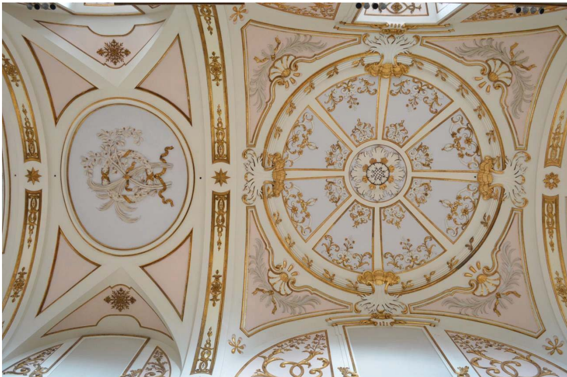
Fig. 10. Detalle de la cubierta actual de la iglesia. Fuente: autora.
