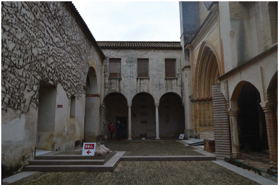
Fig. 25. Patio de delante de la iglesia. Fuente: autora.
