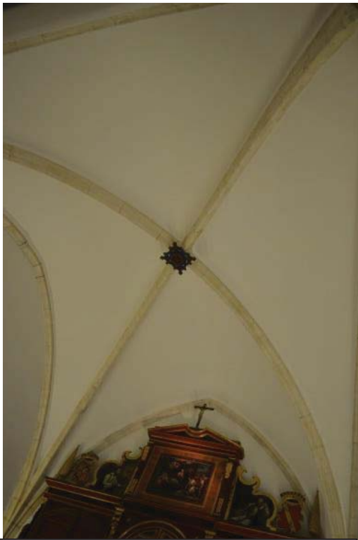
Fig. 68. Bóveda de la sacristía. Fuente: autora.
