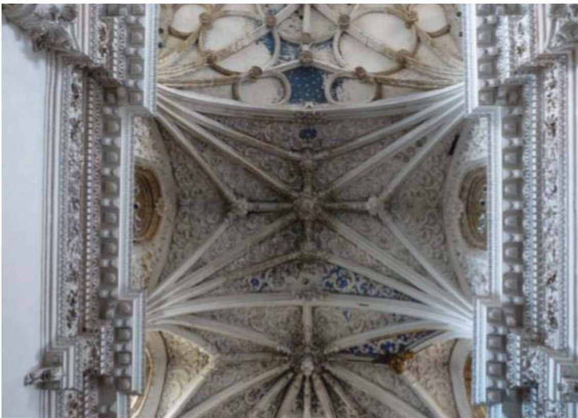
Fig. 79. Detalle de las bóvedas de la capilla mayor. Fuente: ROMERO MEDINA, R. y ROMERO BEJARANO, M., ob. cit. , p. 39.
