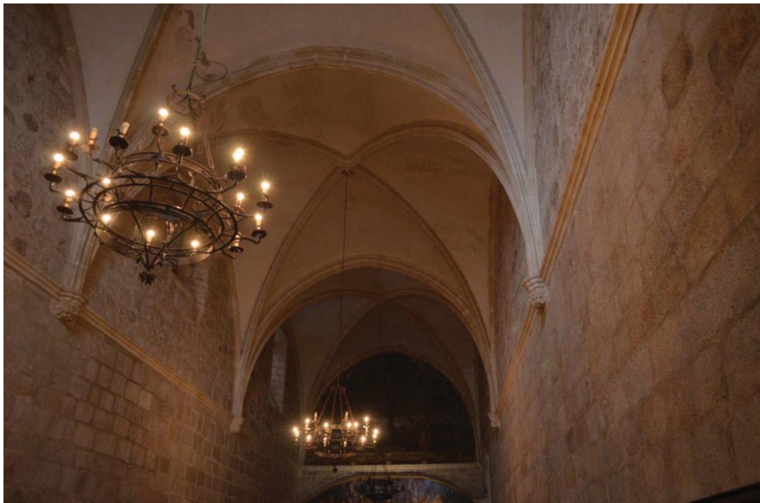
Fig. 18. Interior del refectorio. Fuente: autora.
