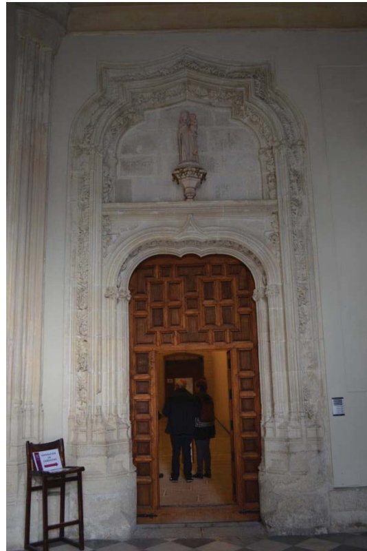
Fig. 7. Portada que conecta el atrio con el claustro mayor. Fuente: autora.
