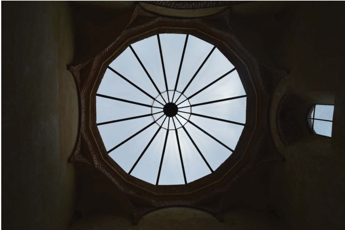
Fig. 85. Cúpula del espacio principal de la sala capitular. Fuente: autora.
