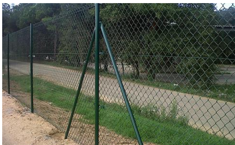
Imagen 7. Ejemplo vallado con malla de simple torsión, 2m de alto (Vimasa S.L.).
