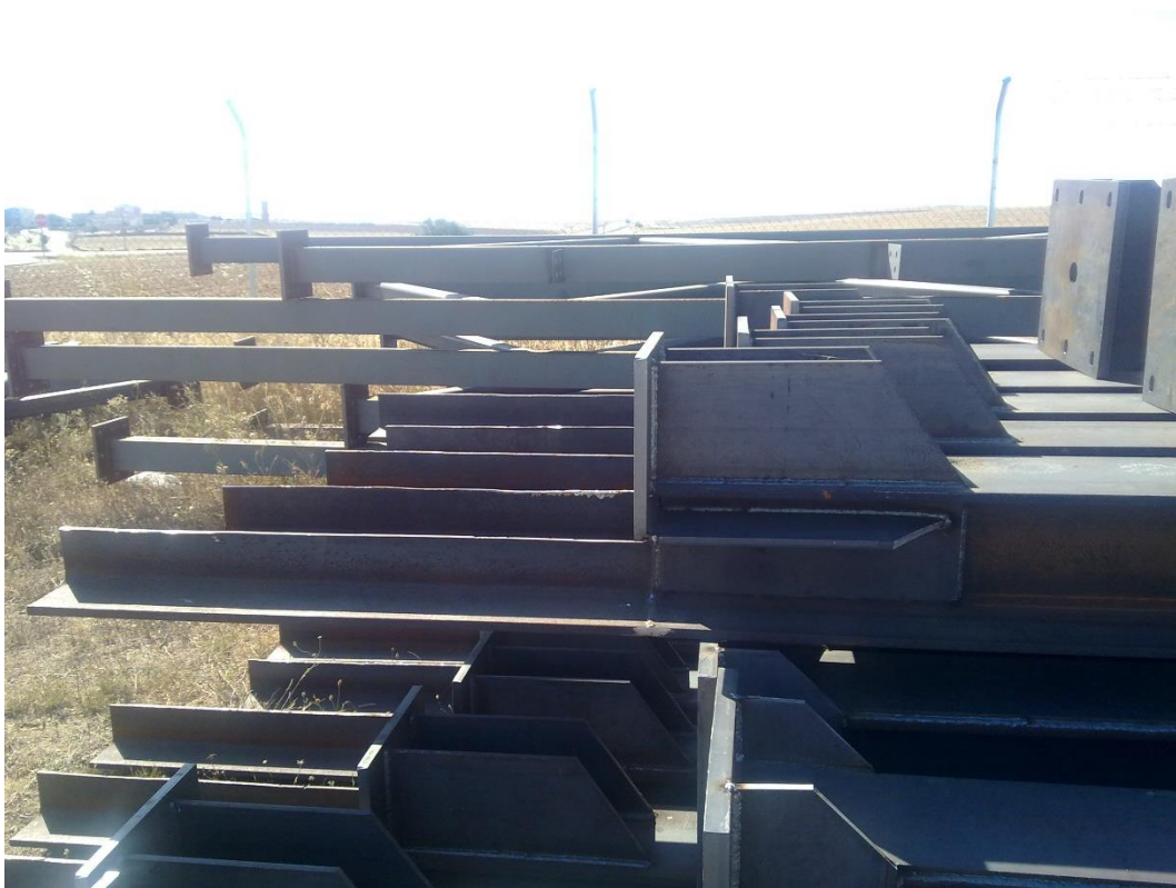
Figura 11-2 Pilares antes de ser pintados
