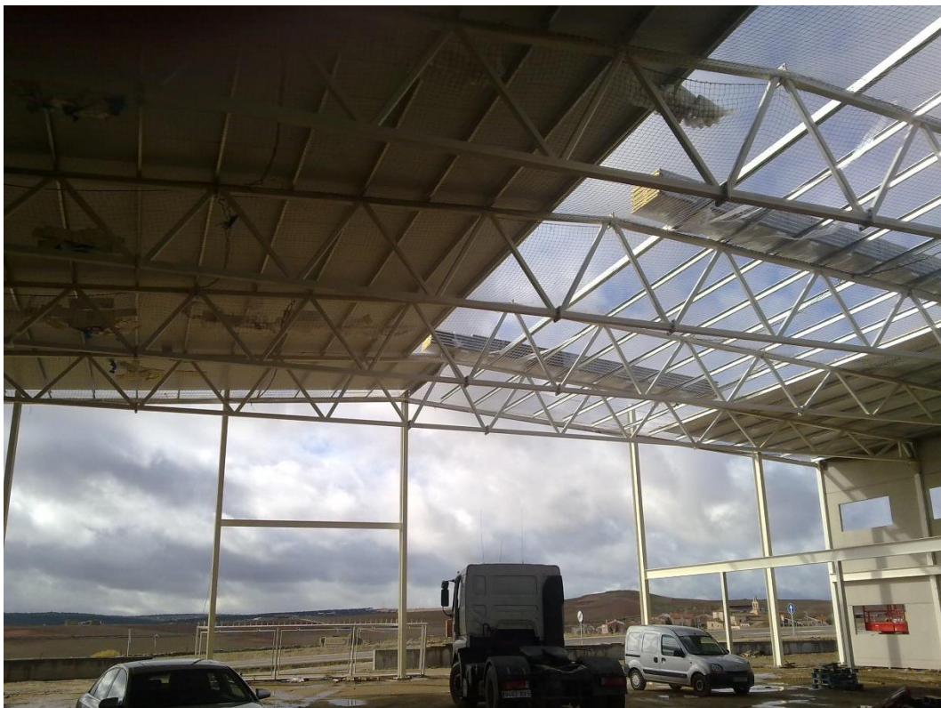
Figura 11-4 Montaje de la cubierta
