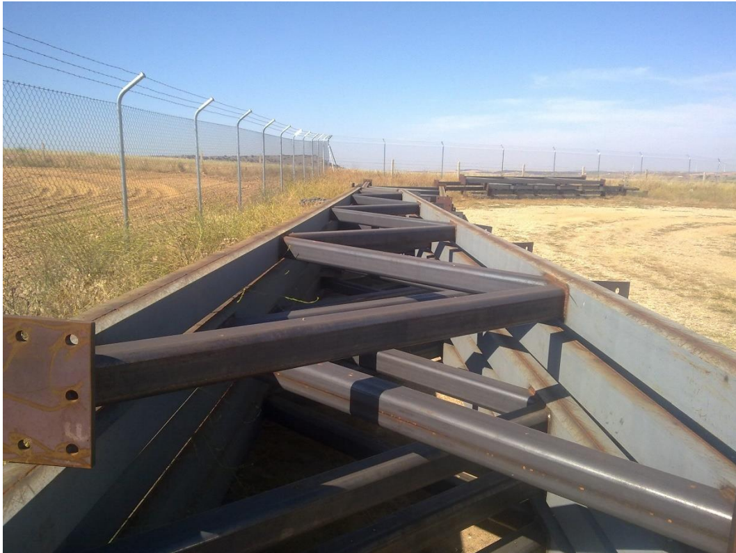
Figura 11-1 Cerchas antes de ser pintadas
