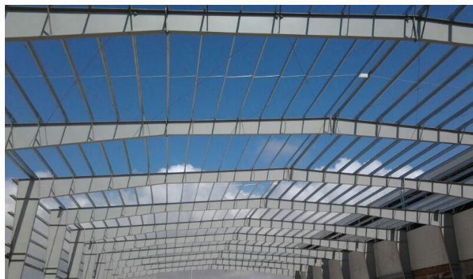
Figura 4.4.6-3 Detalle arriostramiento cabios con correas
