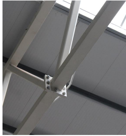
Figura 11-5 Detalle unión cercha
