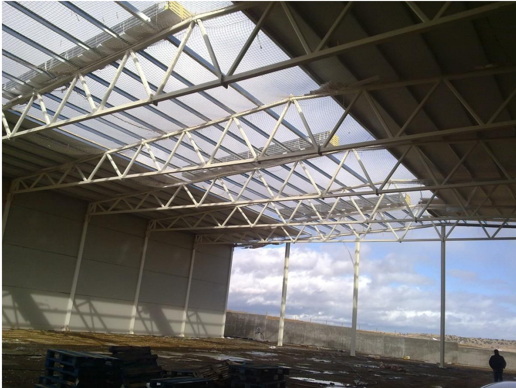
Figura 11-3 Montaje de la cubierta
