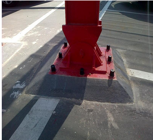
Figura 4.4.1-1 Detalle nudo articulado
