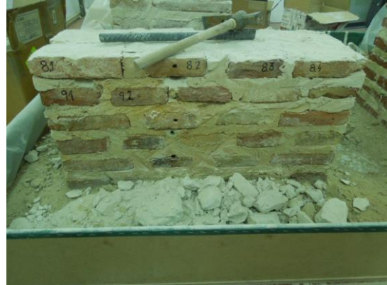
Imagen 143. Desmontaje del muro con los ladrillos numerados.
