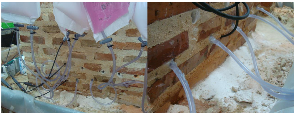
Imagen 93. Imágenes del proceso de hidrofugación de los muros de asta y media.
