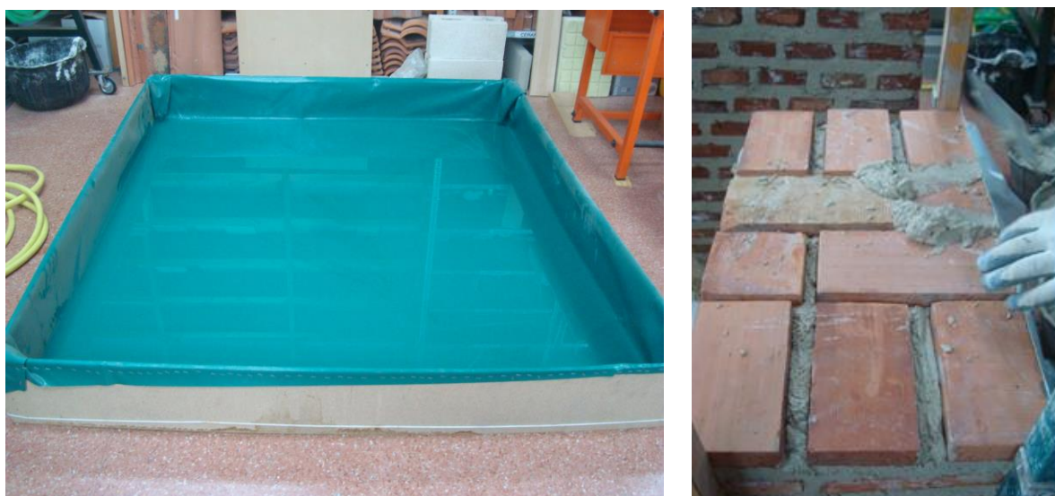
Imagen 92. Imágenes del proceso de construcción de la balsa y de los muros.
