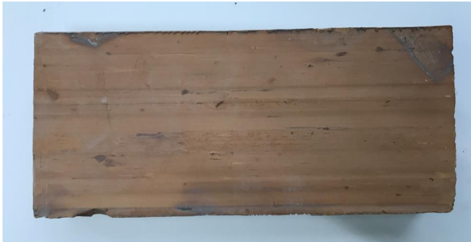
Imagen 39. Ladrillo de ejecución moderna tipo "Santoveña"
