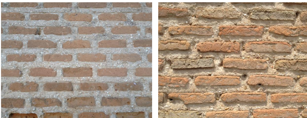
Imagen 40. Fábricas de ladrillos de tejar con juntas de argamasa con distintas configuraciones
