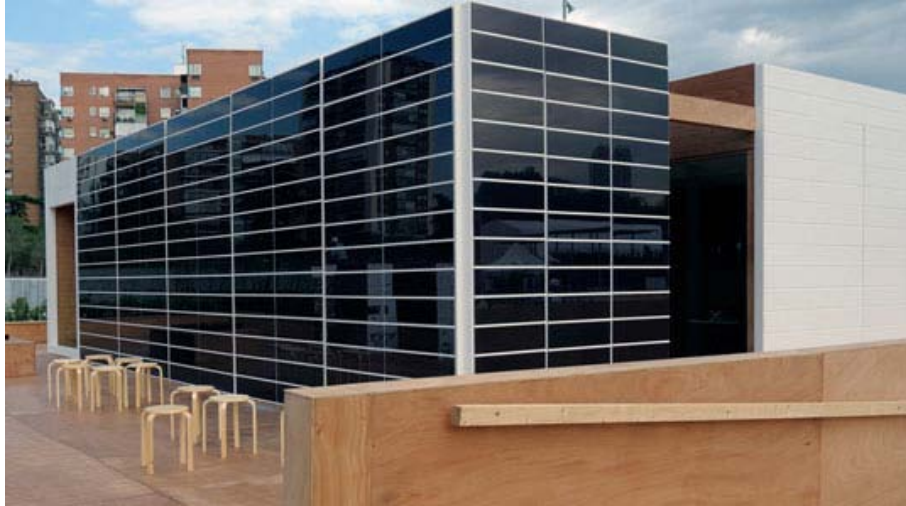
Fig. 10 Integración de vidrios fotovoltaicos de tecnología de silicio amorfo en la fachada de la SMLHouse. Solar Decathlon 2011.
