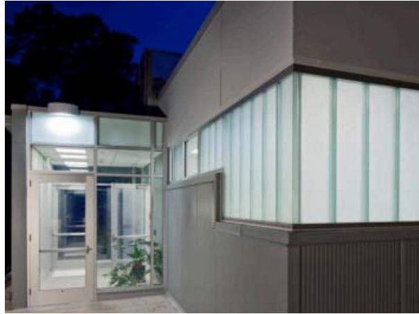
Fig. 7 Integración de U canal glass de Pilkington con Lumira Aerogel
