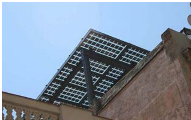
Fig. 9 Realización de un elemento de sombreado en el centro de Barcelona mediante tecnología de silicio cristalino.
