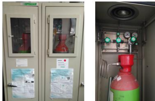
Fig 3.6. Combustibles en botellas de alta presión y sus medidas de seguridad.
