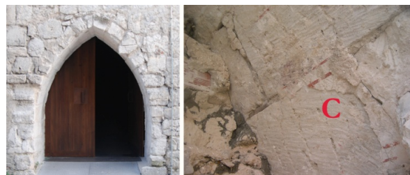
Fig. 19. Fotografías de la puerta lateral. Restos de pintura llagueado doble en color ocre / rojo. S. XV.
