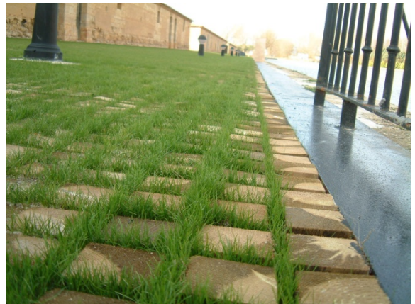
Fig. 9. Proceso de ejecución del adoquinado de madera
