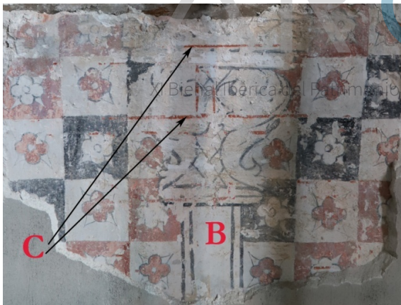
Fig. 21. Detalle de superposición de capas pictóricas en la vidriera baja del ábside. B. Pintura de fondo damero s. XIV. C. Pintura llagueado sillar junta doble ocre rojo s. XV
