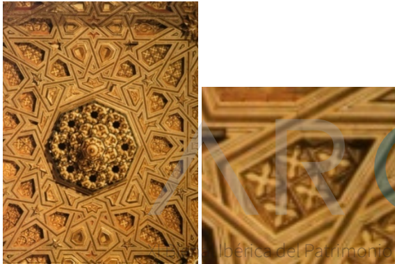
Fig 15. Detalle del Alfarje, Santa Clara, Tordesillas. 1.340.
