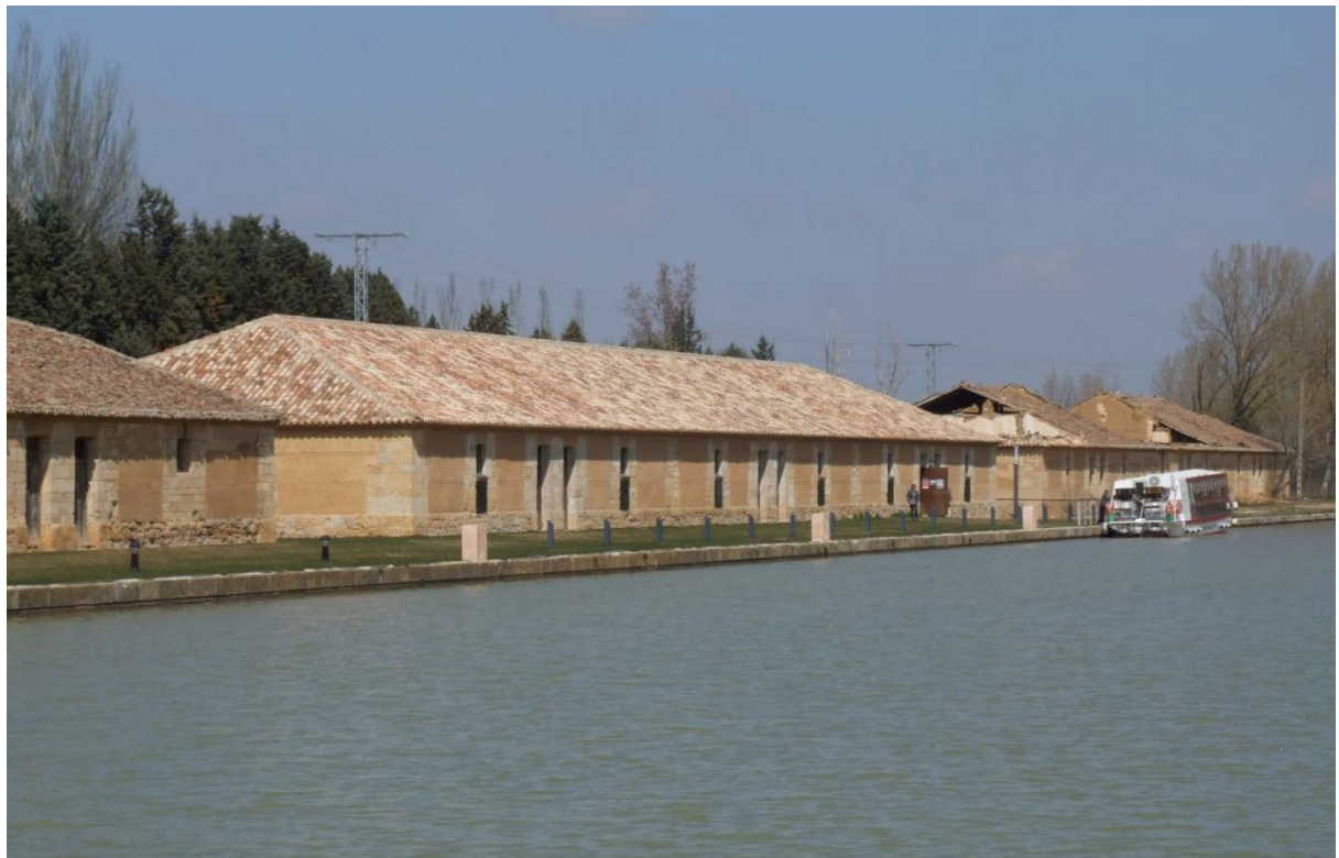
Fig. 10. Vista general del Camino de Sirga desde la margen izquierda de la Dársena del Canal de Campos
