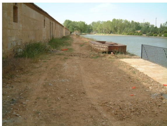
Fig. 5. Estado del Camino de Sirga antes de la intervención
