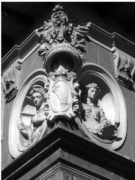
33. Casa del marqués de Valverde de la Sierra. Medallones de la esquina.
