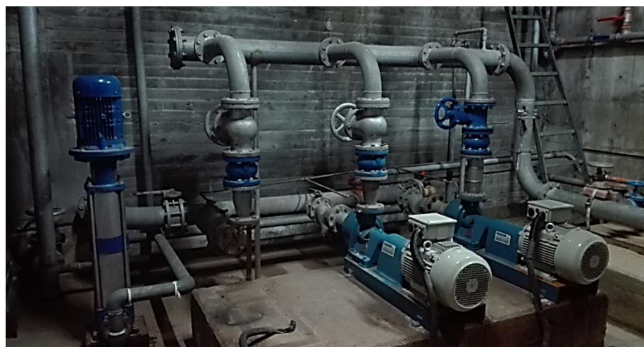
Imagen 13. Bombas del grupo de presión (abastecimiento de agua y riego), situadas en el sótano de la tribuna oeste.
