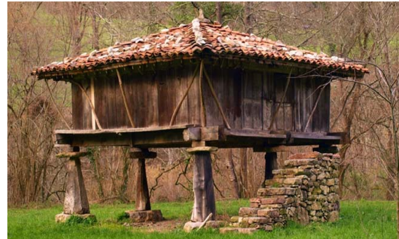
14. Hórreo asturiano con estructura de madera sobre pegollus de piedra
