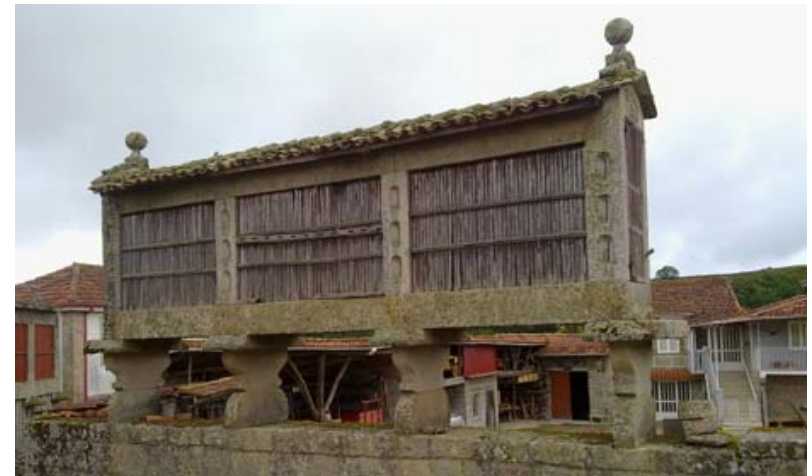
15. Hórreo gallego de estructura de granito, con cepas apoyadas sobre un muro
