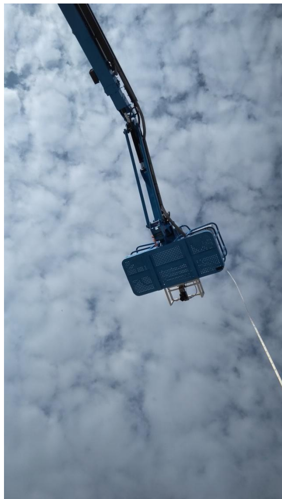
Fig. 64: Elevación de la cesta a 21 m de altura
