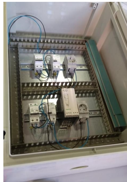
Fig. 55: Armario en fase de montaje 2
