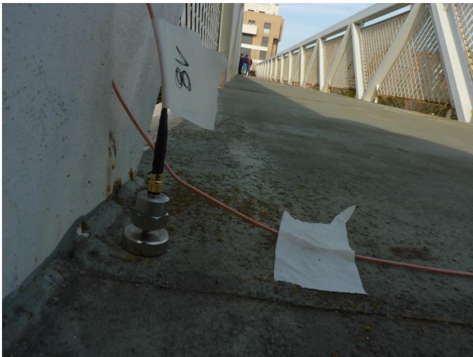
Ilustración 25- Acelerómetro 8V (vertical) colocado con cable fijado al suelo
