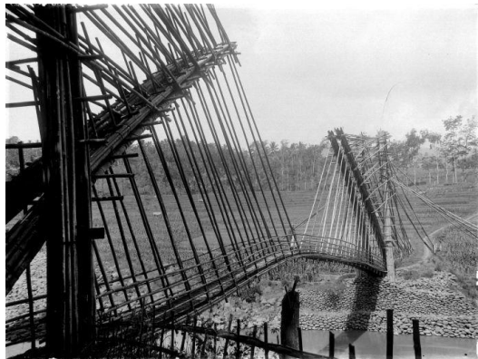
Ilustración 1- Puente de bambú sobre el río Serayu (Java, Indonesia)
