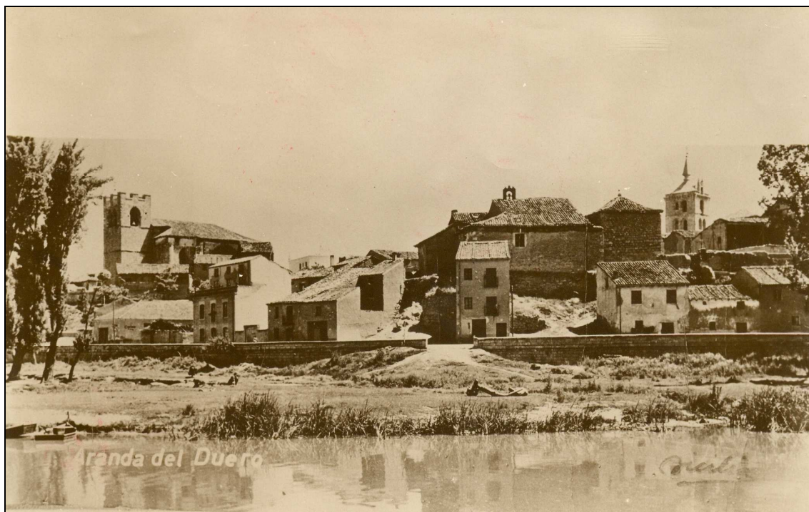
Imagen 19: Ermita de San Lorenzo poco antes de su derrumbe (CBMAD).
