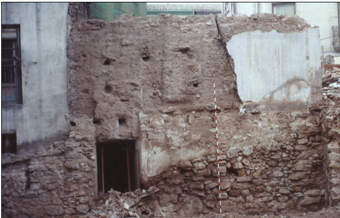
Imagen 4: Detalle del lienzo identificado en la excavación arqueológica de la calle Santa Lucía nº 6.
