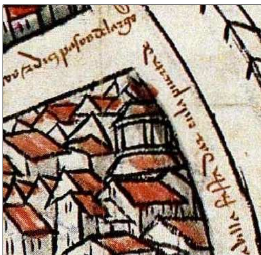
Imagen 33: Detalle de la cubierta en forma de cúpula.
