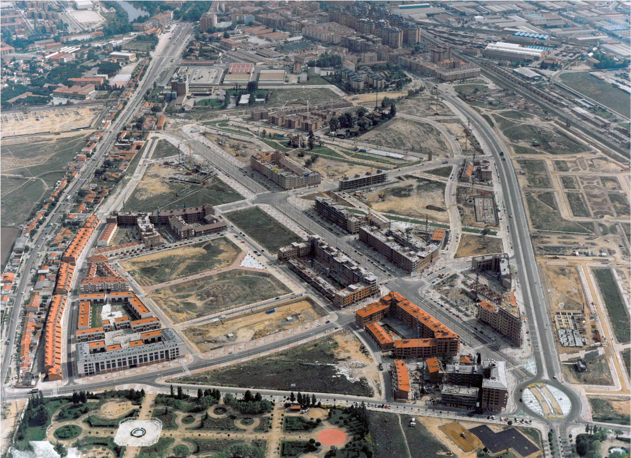
Figura V.12. Vista de las obras de urbanización y construcción en los planes parciales de Parque Alameda (en el centro), Paula López (a la derecha) y Las Villas Norte (arriba a la izquierda).
