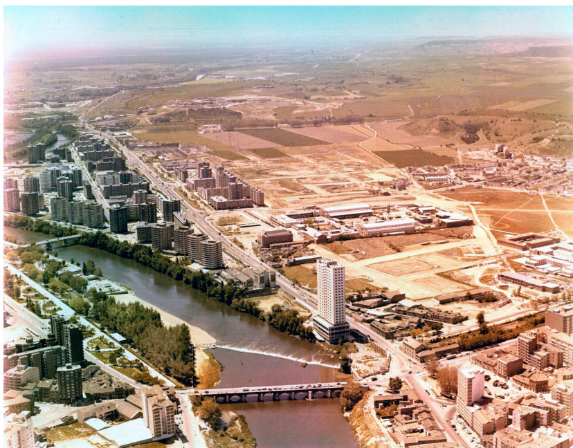
Figura IV.14. Obras de urbanización de la segunda fase de Huerta del Rey.
