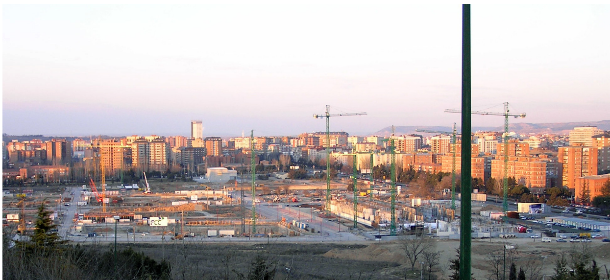
Figura VI.3. Obras de edificación en el plan parcial Villa del Prado.
