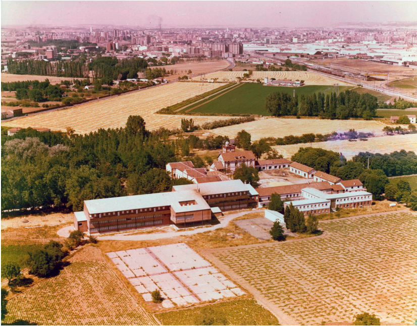
Figura IV.16. Vista de los terrenos al sur de la ciudad.
