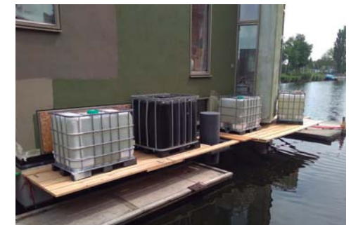
FIG.67_ Conexión de las instalaciones antes que el acceso
