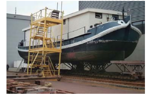
FIG.35_ Casa barco fuera del agua durante el mantenimiento realizado cada 5 años.
