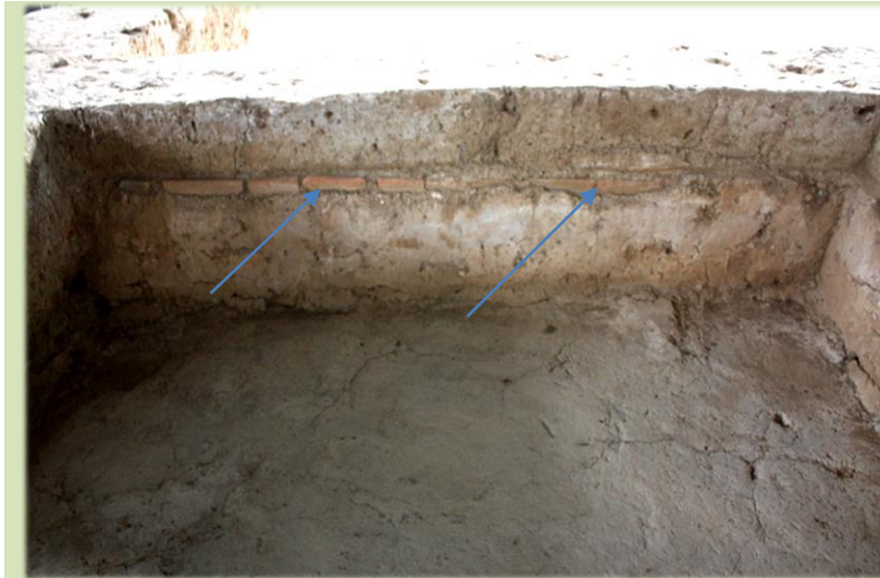
Figura 336: Vista de la pared oeste de V-34; la flecha indica dónde acaba el zócalo de piedra y ladrillo y comienza el tapial. CGS.
