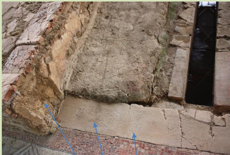
Figura 274: Vestíbulo norte: Detalle esquina suroeste, desagüe e impronta del marco de la puerta en el encuentro con el peristilo.
