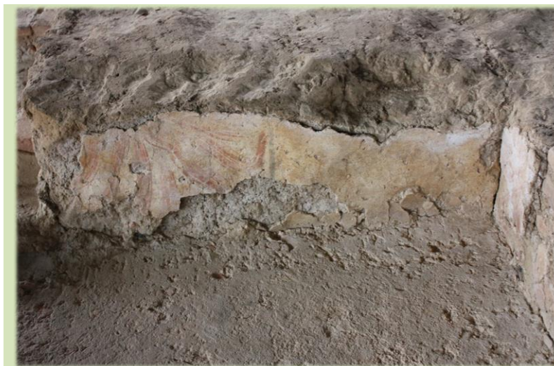
Figura 405: Macizado de tapial en la escalera norte revestido de pintura al fresco. CGS.
