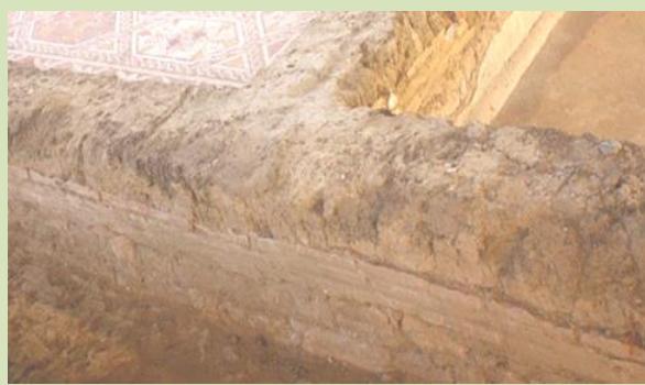
Figura 284: Muro interior del pórtico norte, a la altura de las habitaciones 18 y 19. CGS.
