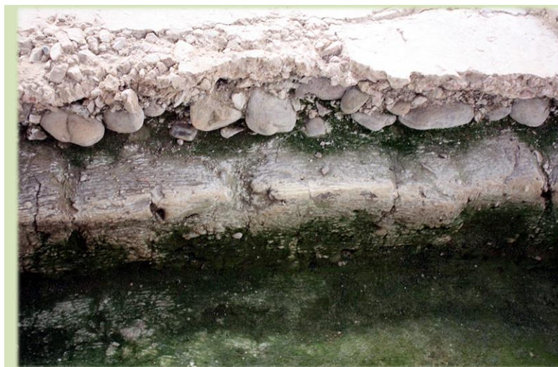
Figura 407: Adobes en la canalización radial norte del hipocausto de la B-12. CGS.
