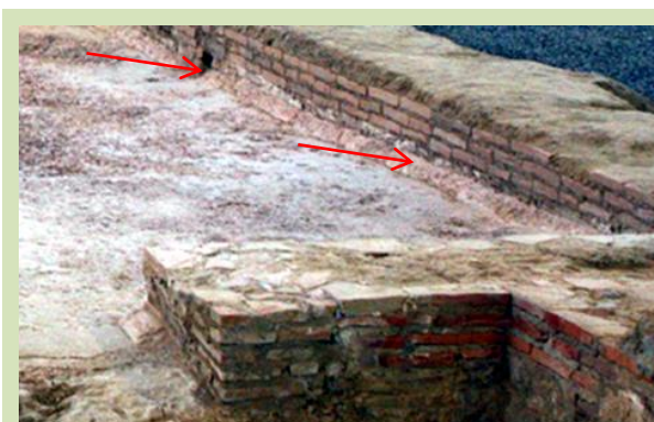
Figura 289 Vista del desagüe, rodapié, y muros en la esquina suroeste de la torre oriental, V-38, desde el pórtico norte de La Olmeda. CGS.
