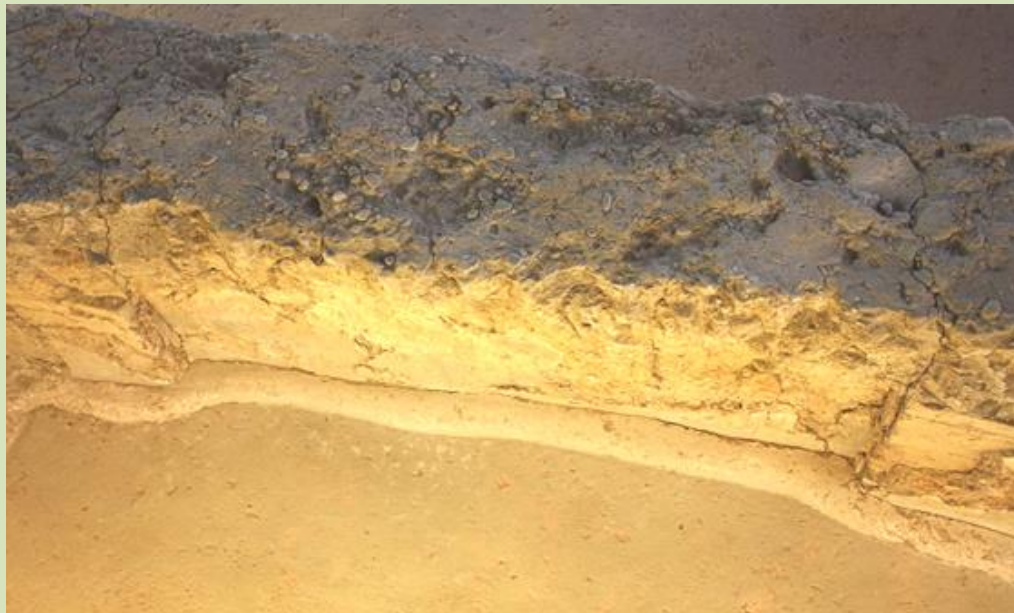
Figura 256: Reforma en la habitación V-19, anulación del paso a la V-20, con muro de tapial, con retranqueo también seguido por el rodapié. CGS.
