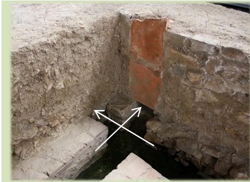
Figura 525: Conexión de galerías y chimeneas en la esquina noreste. CGS.
