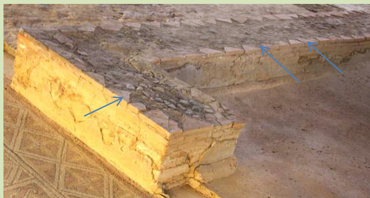
Figura 268: Vista de la entrada en la V-21, composición de los muros de carga con fragmentos de ladrillo triangulares. CGS.
