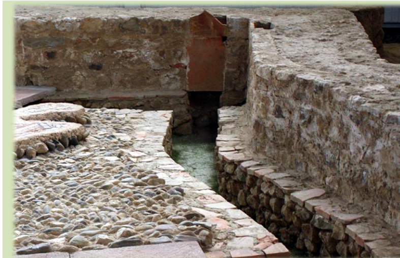
Figura 435: Esquina sureste del salón de baños, muro tripartito restaurado, hipocausto...
