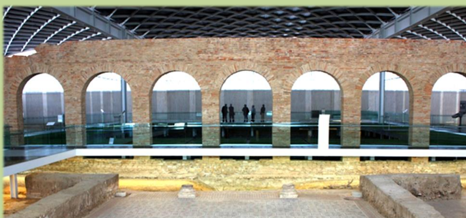
Figura 118: Foto de la fachada con arcos desde el vestíbulo, V-03. CGS.
