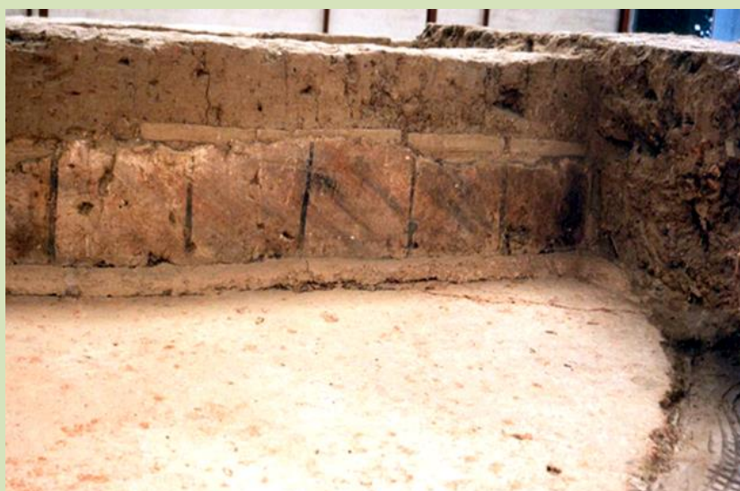
Figura 215: Muro sur de la habitación V-11 con revestimiento de pintura, hiladas de ladrillo y pavimento de signinum roto por la zanja en la esquina inferior derecha. CGS.
