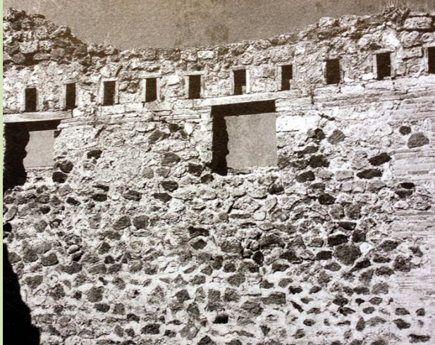
Figura 450: Habitáculos para el apoyo de las vigas de un suelo, enmarcados con ladrillo. Pompeya (VI,14,31) 673 .
