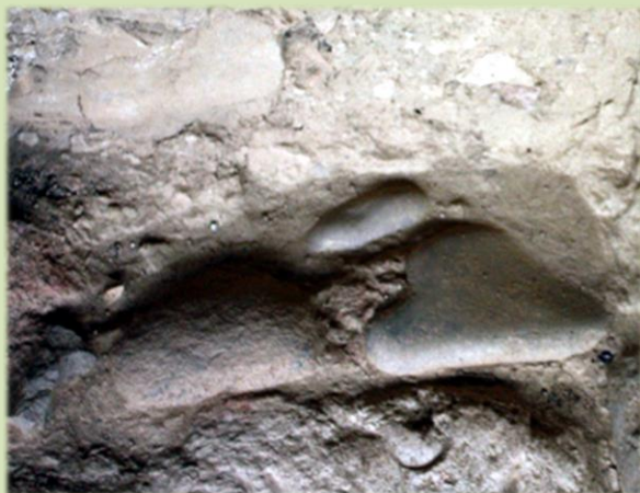
Figura 431: Cimiento de mayor anchura que el muro en la habitación V-34. CGS.
