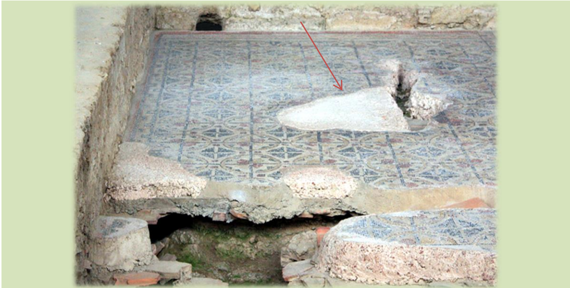
Figura 515: Zona noreste de la habitación V-32, la flecha indica la canalización interior del sector II, en una cata del mosaico realizada por los expoliadores.... CGS.
