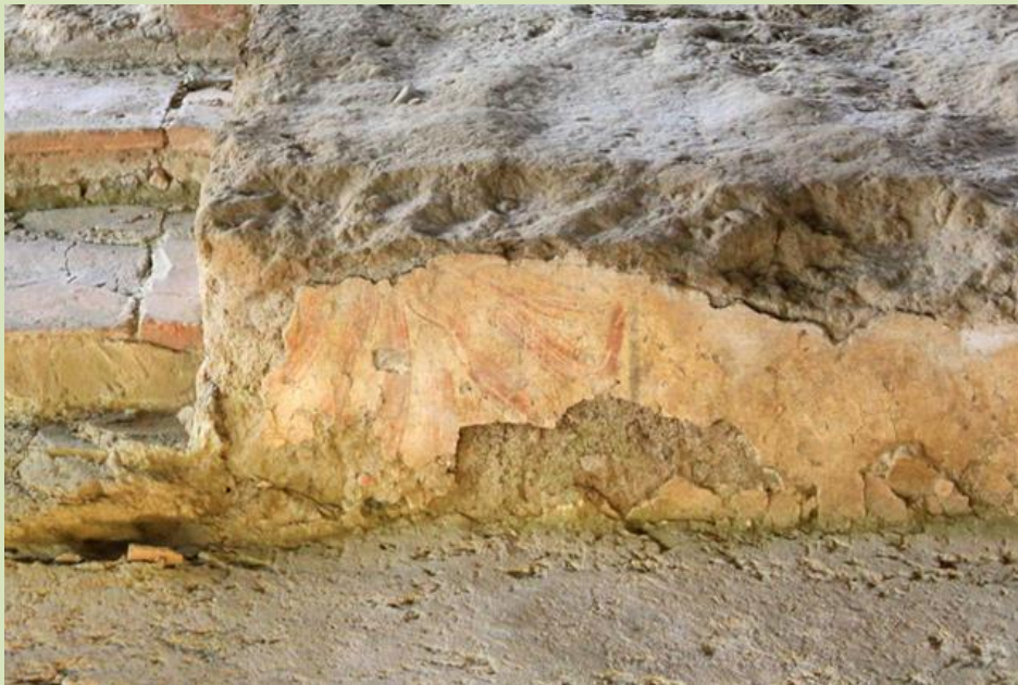
Figura 278: Revestimiento y acabado de pintura en el vestíbulo de la escalera norte. CGS.
