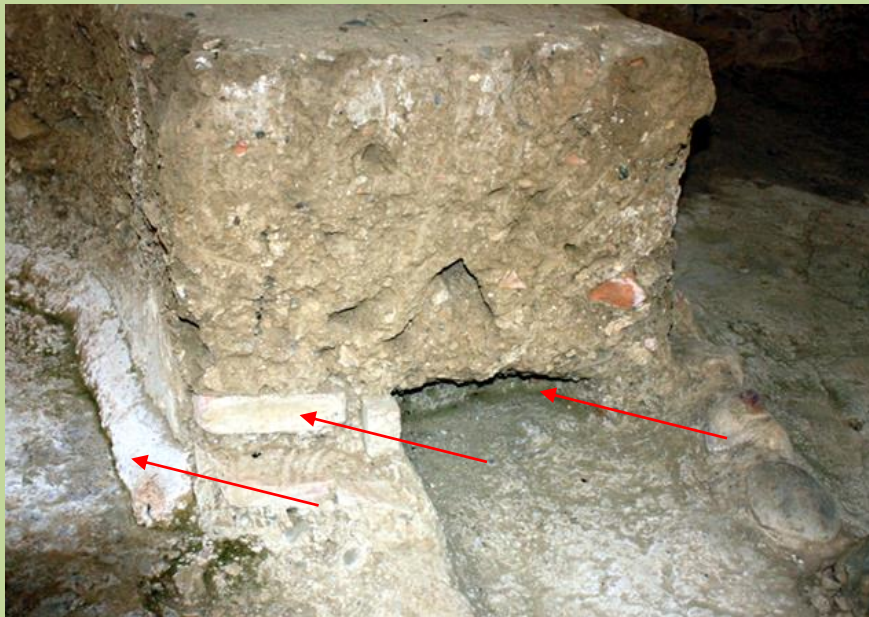
Figura 154: Acceso a la torre octogonal, V-36
