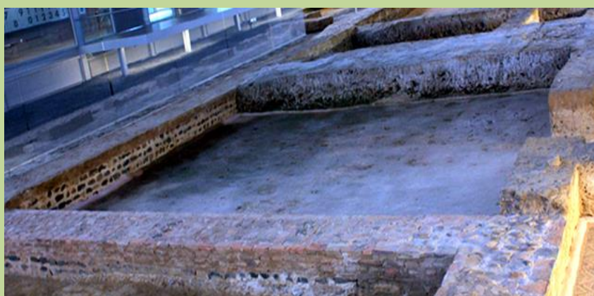
Figura 174: Habitación V-08, en primer término muro oriental. CGS.
