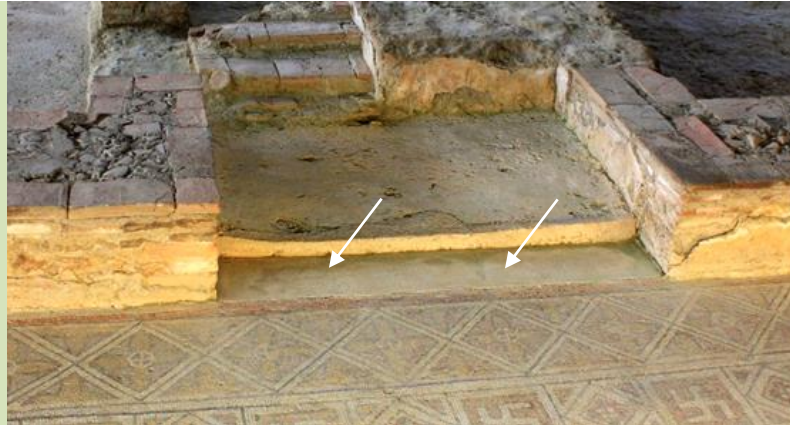
Figura 498: Huella dejada por el marco de la puerta que accedía a la escalera norte de la villa, desde el peristilo norte, V-15. CGS.
