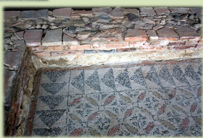
Figura 306: Esquina noroeste de la V-27; muros, cenefa de borde del mosaico y dibujo seriado general del mismo. CGS.
