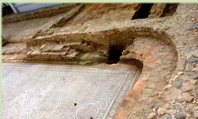
Figura 344: El banco corrido en la esquina sureste de la B-02, con el desagüe hacia las letrinas. CGS.
