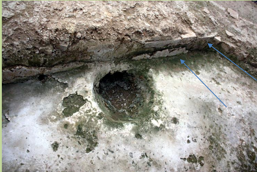
Figura 151: Pozuelo en torre octogonal, V-37, revestimiento interior, hilada de ladrillo y tapial. CGS.
