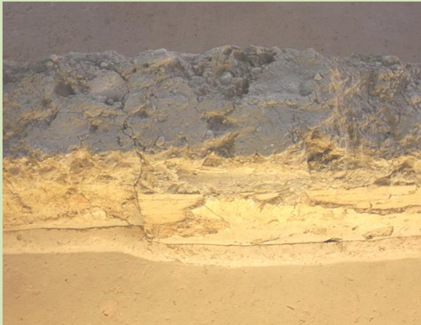
Figura 257: El plano interior del retranqueo de la reforma de la habitación V-19 se corresponde con el de la zona superior del muro cuando acaban las hiladas del ladrillo. El rodapié sigue el retranqueo. CGS.
