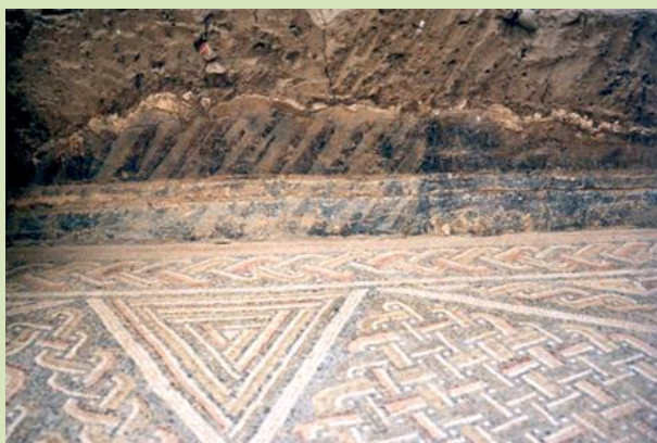
Figura 222: Revestimiento de pintura en el muro norte. CGS.
