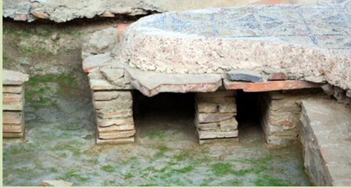
Figura 512: V-32, detalle del hipocausto, sector I, pavimento de mosaico sobre grandes ladrillos o tégulas planas apoyadas en los pilae. CGS.
