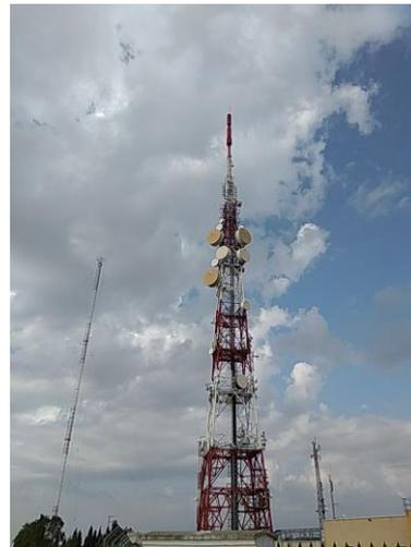
**FIGURA 41. RADIOENLACES EN ESTACIÓN BASE (IZQUIERDA) Y RADIOENLACES DE MAYOR CAPACIDAD (DERECHA)**
