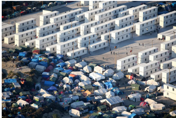
Fig. 18 Vista aérea de la convivencia de tiendas y unidades tipo container en el campo de refugiados de Calais. Septiembre 2016. Fuente: TIME.com
