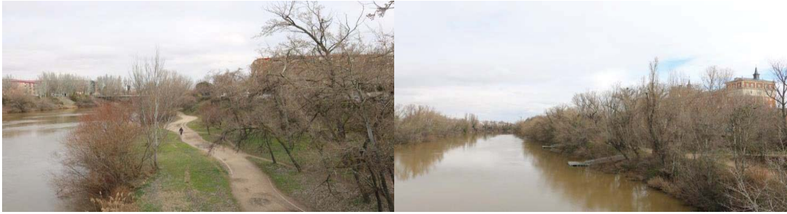
Fig. 57 y 58: Estado de la margen izquierda del Pisuega. Fuente: Fotografías propias
