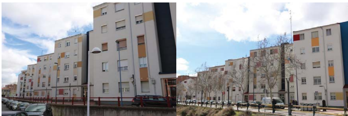
Fig. 63 y 64: Polígono “XXV Años de Paz” tras las obras. Fuente: Fotografías propias
