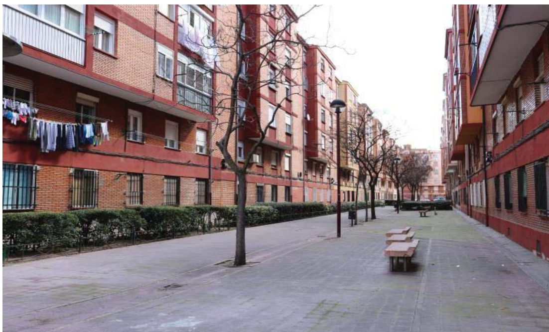
Fig. 46 y 47: E.L.P. degradados. Fuente: Fotografías propias
