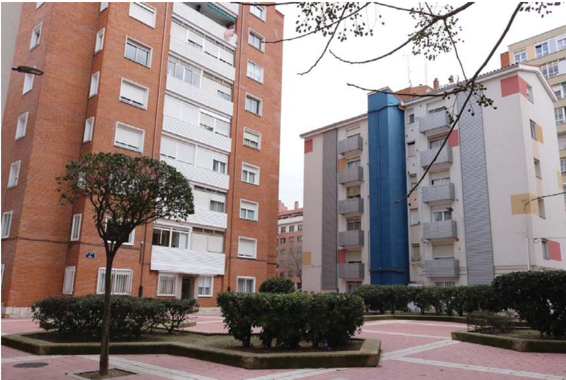
Fig. 17: Espacio libre interior del polígono “18 de Julio”. Fuente: Fotografía propia
