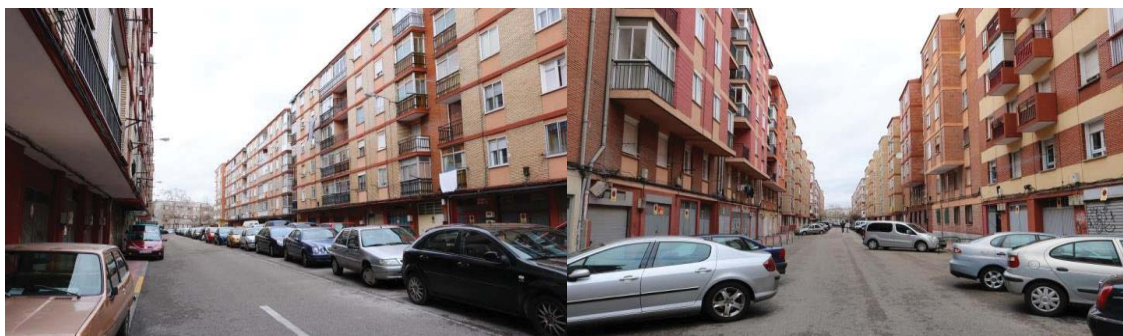
Fig. 72 y 73: Calles interiores invadidas por vehículos y plazas de garaje. Fuente: Fotografías propias
