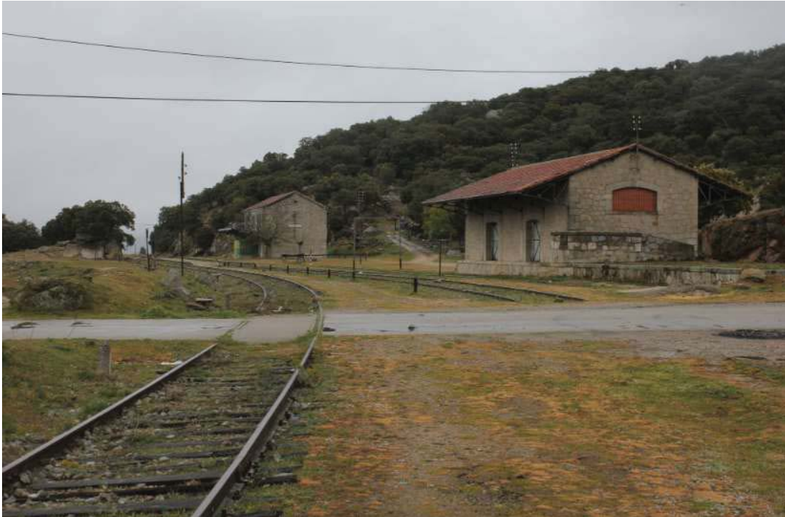
Estado actual de las vías y la infraestructura ferroviaria de la línea Monfragüe-Astorga.
