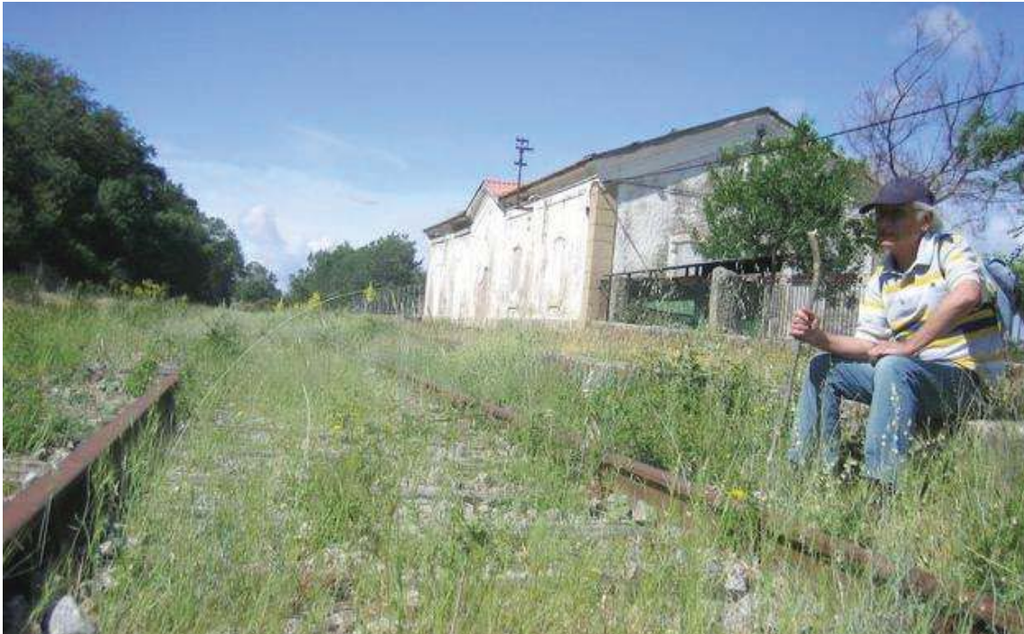
Estado actual de las vías en un tramo de la línea de la Ruta de la Plata.
