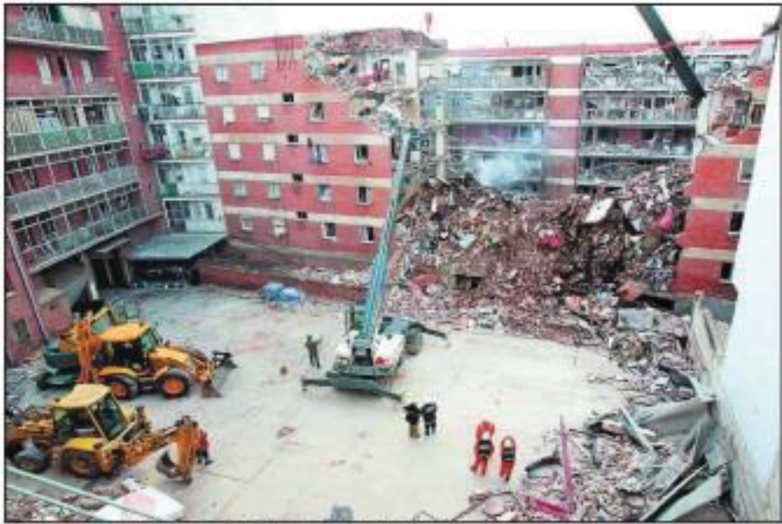
Las máquinas trabajan en las zonas de desmoronamiento tras el colapso del número 1 de la calle de Sanjurjo Arce de Palencia tras la explosión de gas. (A. GARCÍA/AGF)
