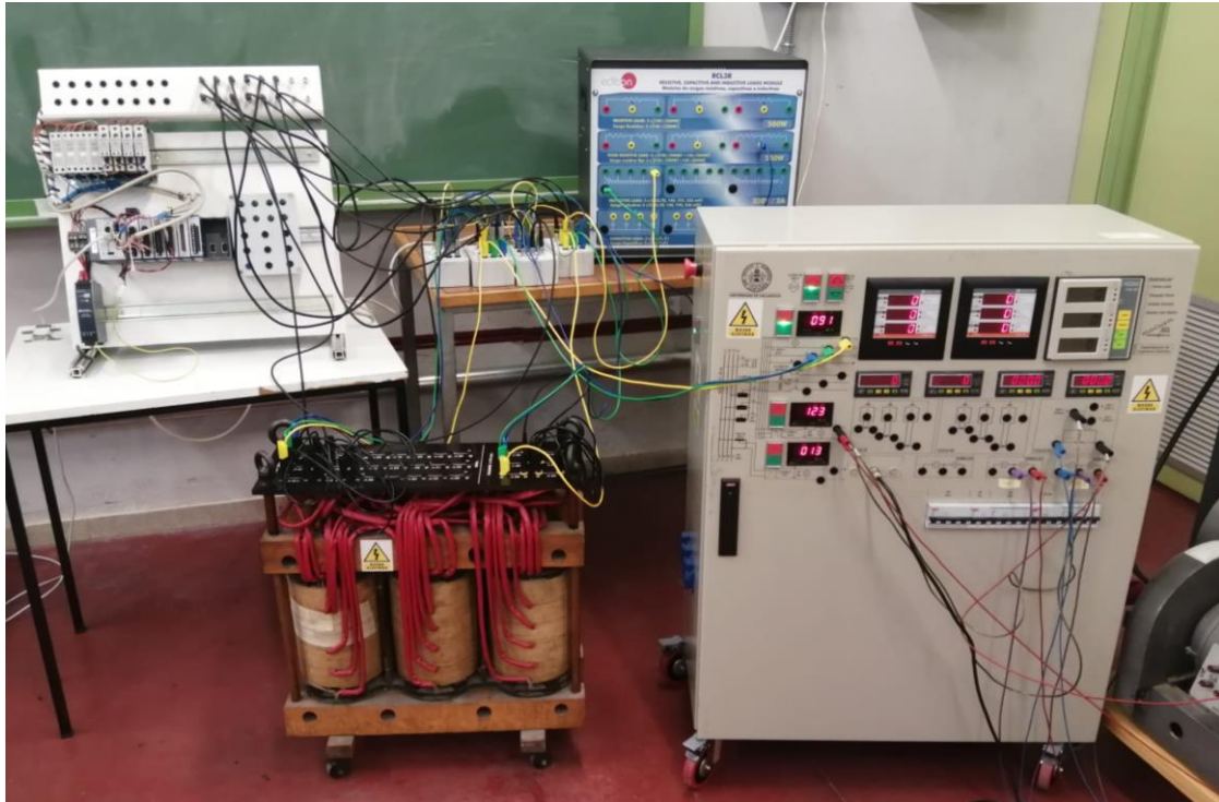
Figura 89. Equipo eléctrico conectado para el ensayo
