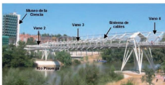
Fig. 3: Vista general de la PMC de Valladolid
