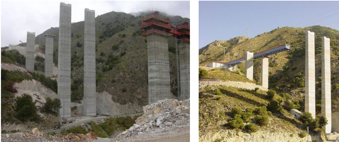
Figura 4.5 Distintas fases constructivas del Viaducto de la Miel de la Autovía A7 del Mediterraneo.
