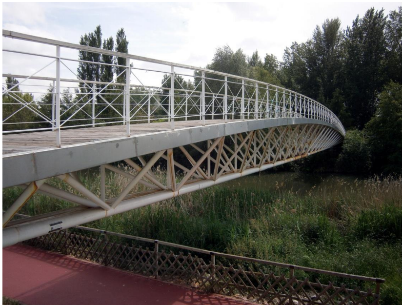
Figura 4.4 Vista general de la pasarela Isla dos agua (PIA) de Palencia
