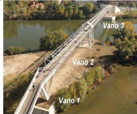
Figura 2: Vista general de la estructura en estudio.
