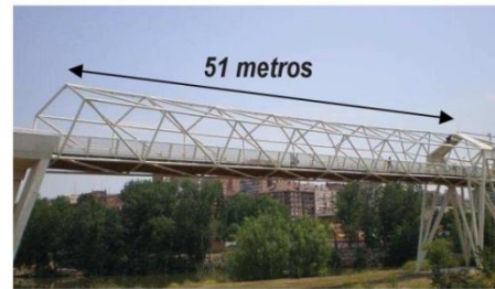
Figura 3: Vista del vano 2.
