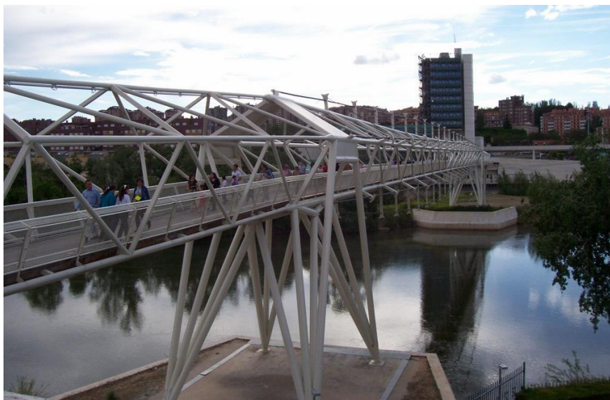
Figura 4.1 Vista general de la pasarela del museo de la ciencia (PMC) de Valladolid
