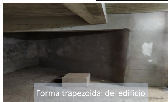
figura 7: Interior del edificio del ingenio en la actualidad, enero de 2020 (fuente: elaboración propia)
