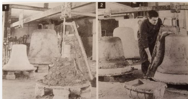
Ilustración 2 Construcción de una campana.
