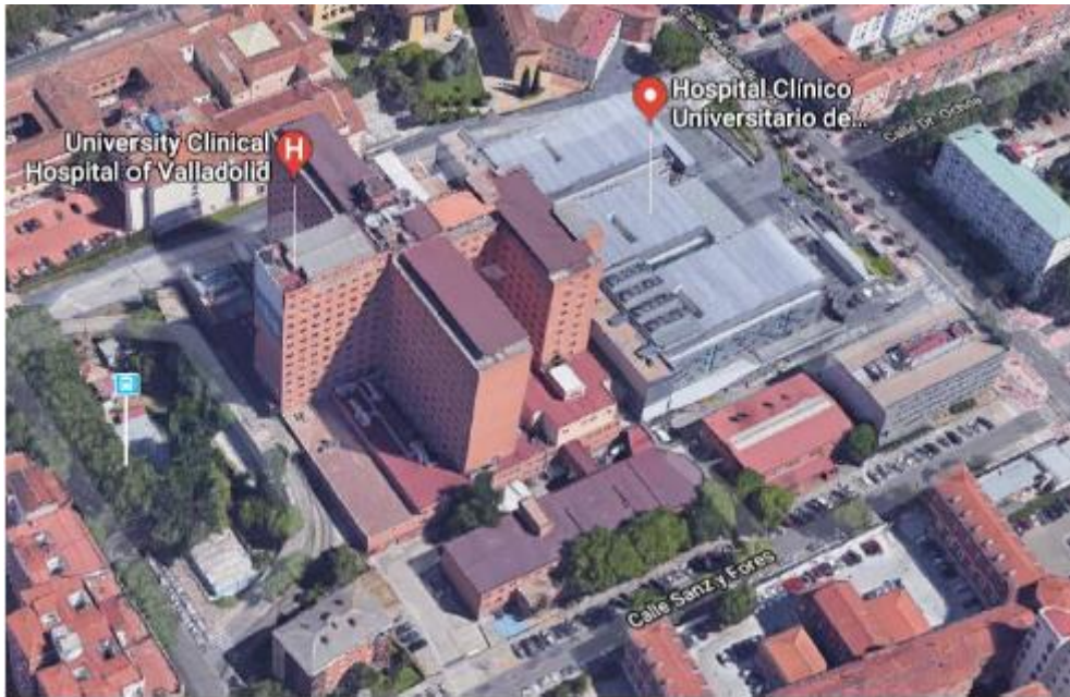
Figura 4.2 Imagen Satélite del Hospital Clínico Universitario de Valladolid. Fuente: Google Maps
