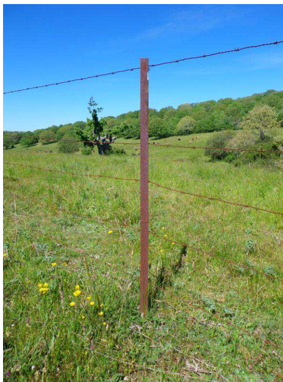
Foto 4: Detalle del cierre perimetral del monte.
