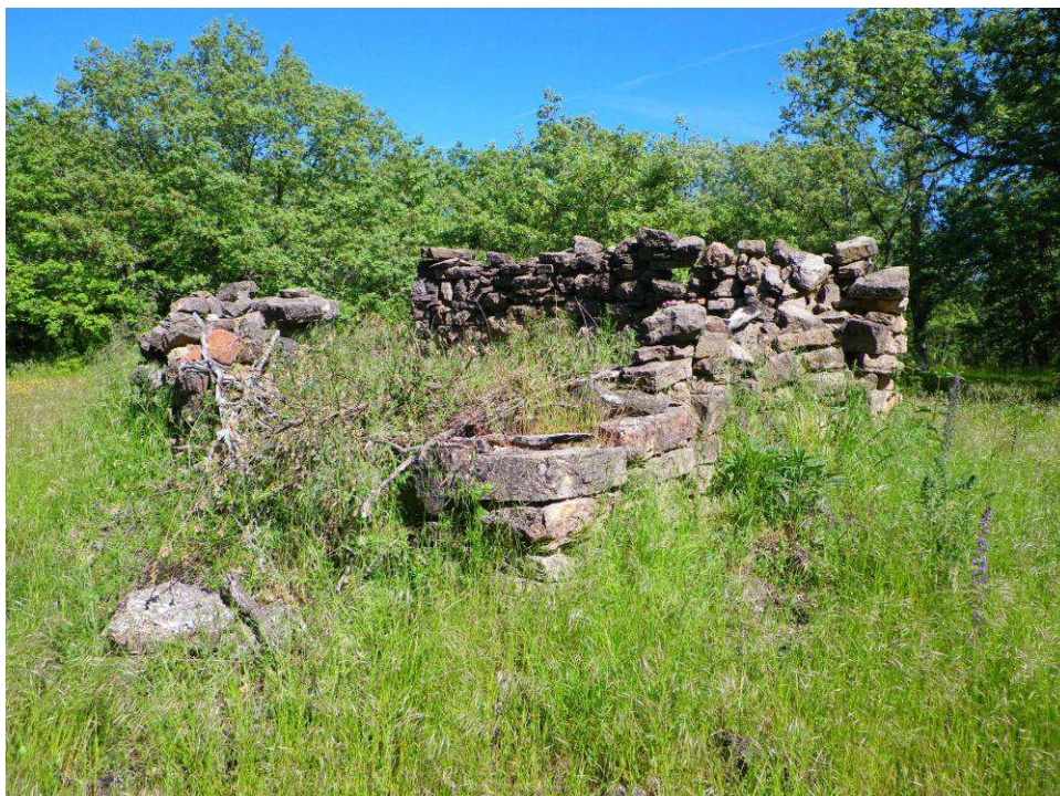
Foto 5: Chozo en ruinas situado en el subrodal 6a.
