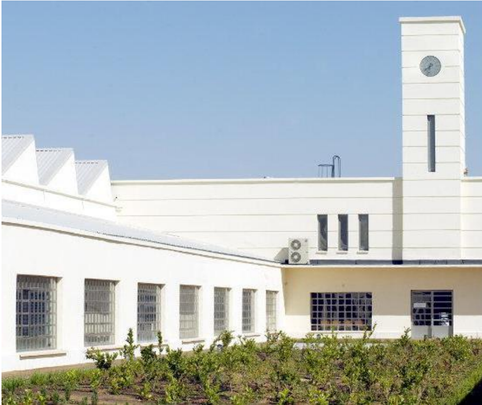
Figura 2.14: bomba de calor colocada en el tejado del Campus La Yutera, en Palencia [W14]
