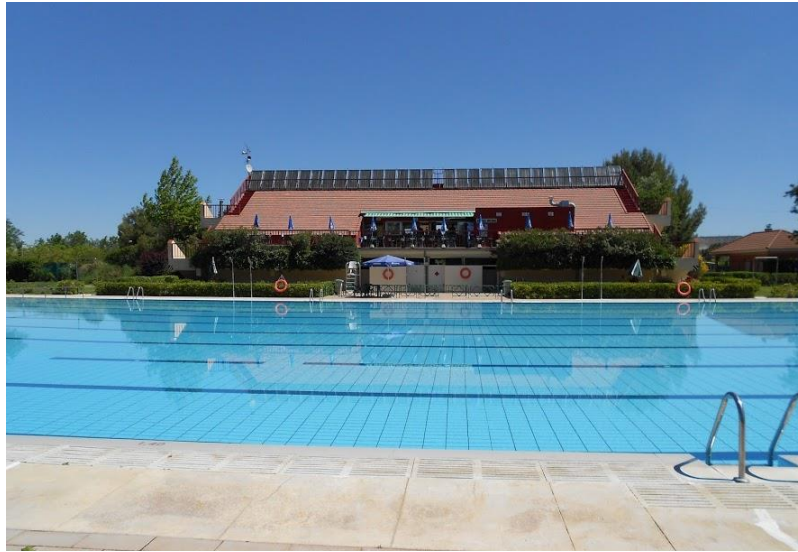
Figura 2.4: instalación de paneles solares en el tejado de las piscinas de Fuente la Mora, en Valladolid [W5]
