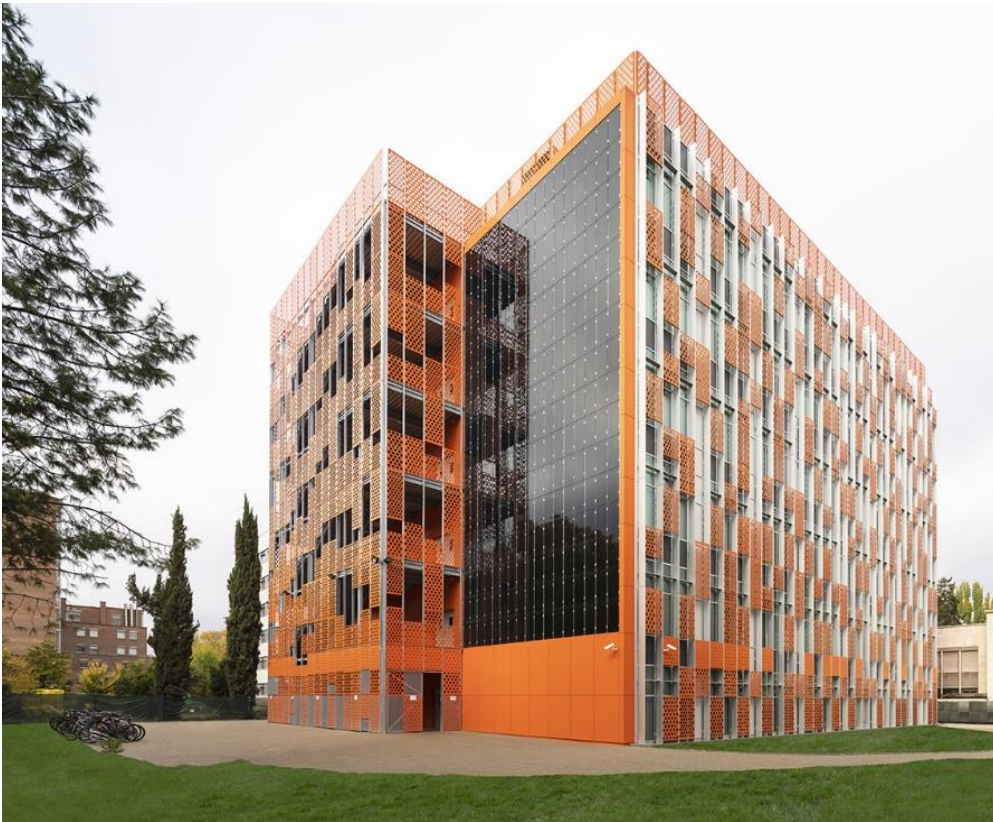
Figura 2.9: Vista de la fachada con paneles fotovoltaicos del Aulario IndUVA de Valladolid [W10]
