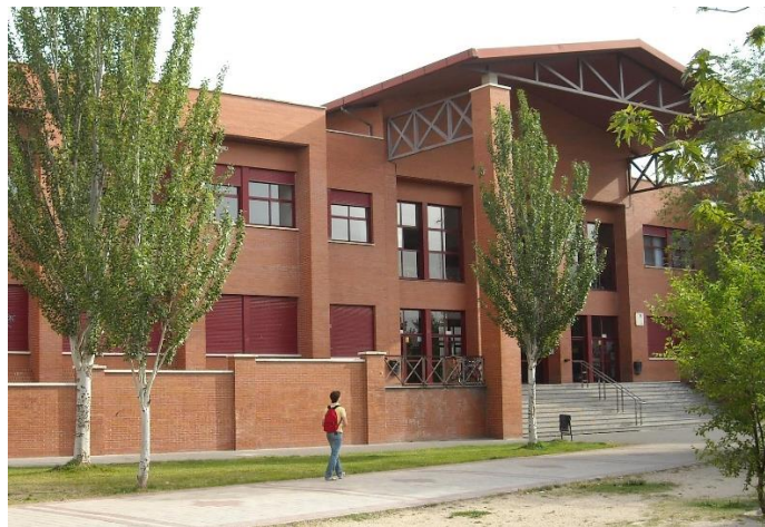
Figura 2.10: Aulario Esgueva, en Valladolid. [W15]
