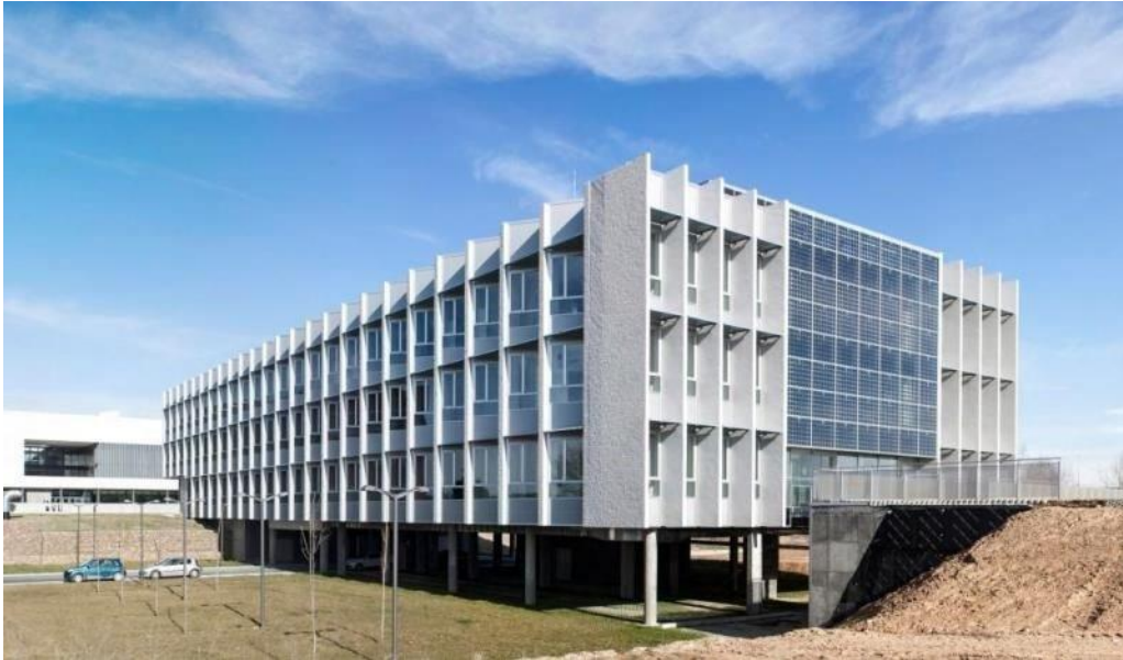
Figura 2.7: Edificio Lucía, en Valladolid. Se puede observar la instalación de paneles fotovoltaicos en la fachada del edificio. [W8]
