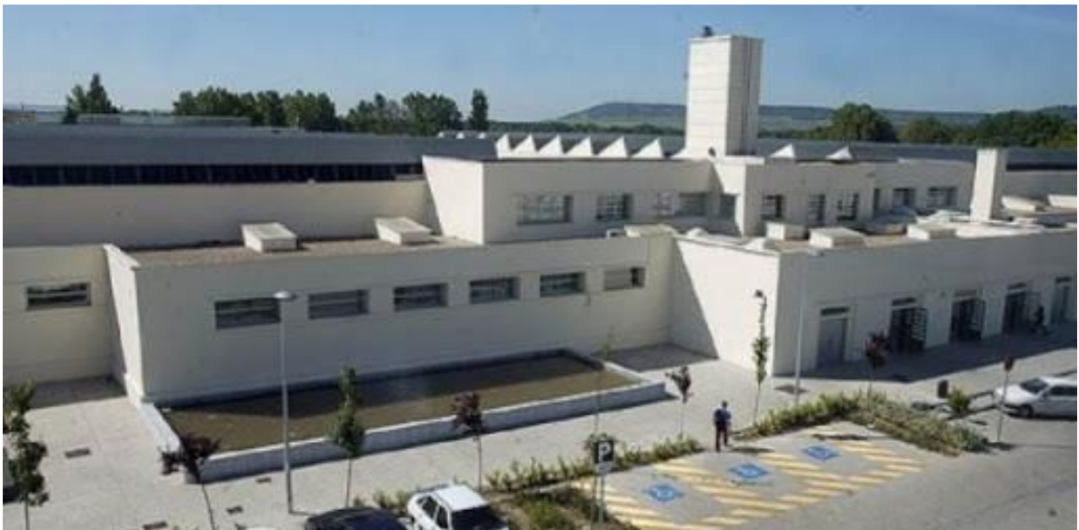
Figura 2.8: Campus la Yutera de Palencia. Se pueden observar los paneles fotovoltaicos en el tejado del edificio principal [W9]
