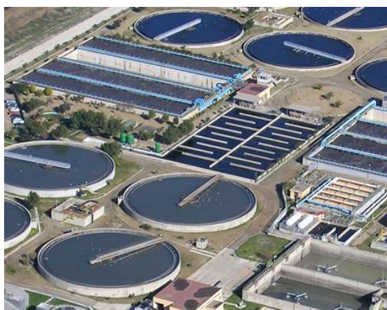
Ilustración 9 Planta depuradora (Valdivia)
