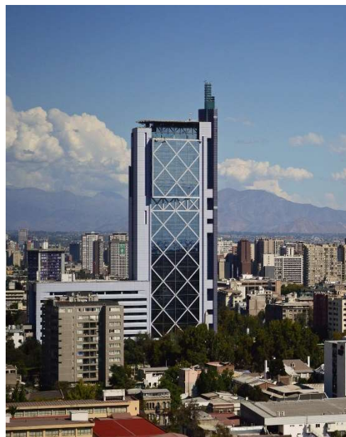
Ilustración 6 Torre Telefónica en Santiago
