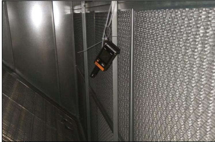
*Figura 3.11.* Monitorización de la entrada de la corriente de ventilación al intercambiador de calor. (Sonda n°2)
