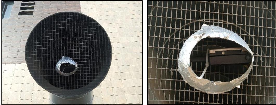
*Figura 3.9.* Monitorización con sonda de medida a la entrada de los pozos provenzales. (Sonda n°4)
