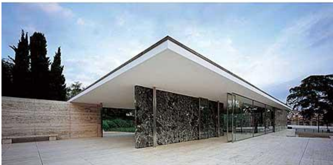
VISTA DE LA CUBIERTA DEL PABELLÓN APOYADA SOBRE LOS MUROS Y BAMABALINAS DESLIZANTES
