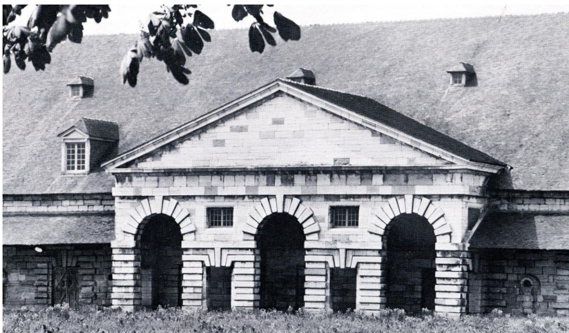
PORTADA DEL EDIFICIO DE LOS HORNOS DE SAL. SALINAS DE CHAUX. C. N. LEDOUX. 1775
