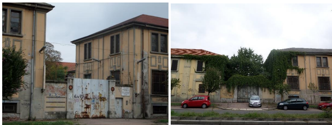
Fig. 49 y 50: imágenes del estado de abandono-degradación de los Almacenes de Baggio.
