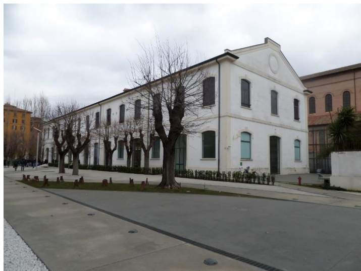
Fig. 7: el único edificio salvado de la demolición del antiguo cuartel Montello.
